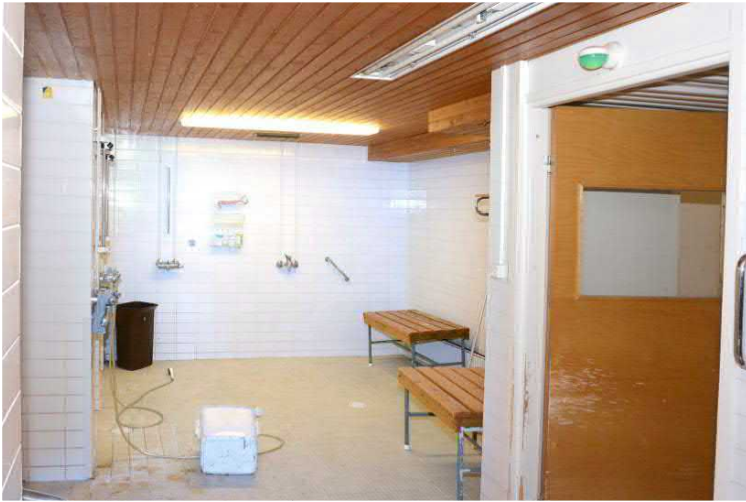
Allasosaston pintoja on osittain uusittu peruskorjauksen jälkeen.
