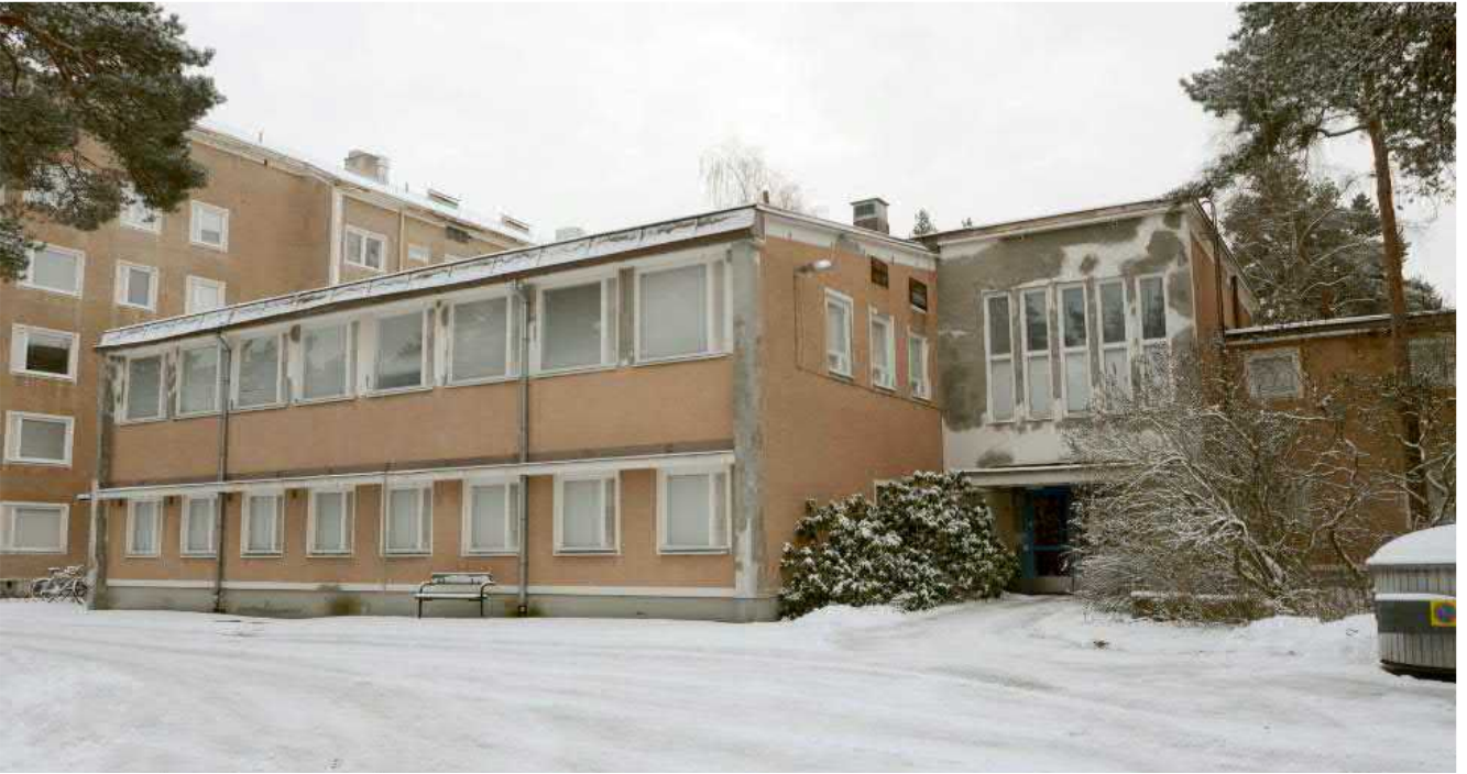
F-rakennuksen pohjoissivu, pääsisäänkäynti oikealla, vasemmalla A-rakennus.
