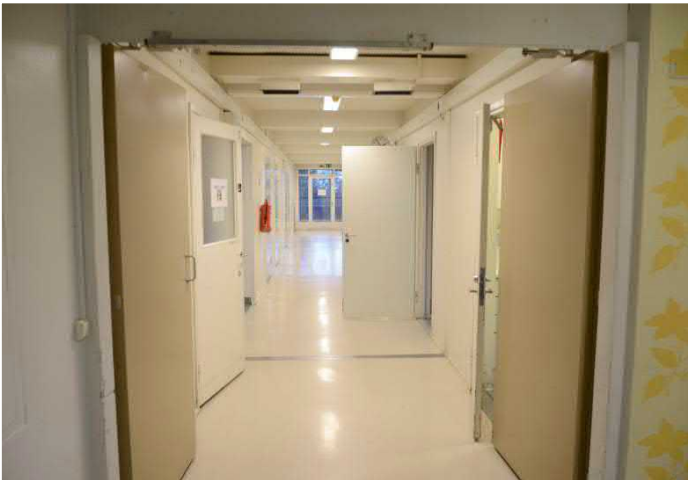
Yllä B-siiven 4. kerroksen pidempi eteläkäytävä. Etualan pariovet on lisätty peruskorjauksessa. Oikealla B-siiven pohjoiskäytävä 2. krs. Lyhyemmille pohjoiskäytävälle ei asennettu ovia. Kuvassa oikalla näkyvä seurusteluhuone avattiin käytävälle 2001.
