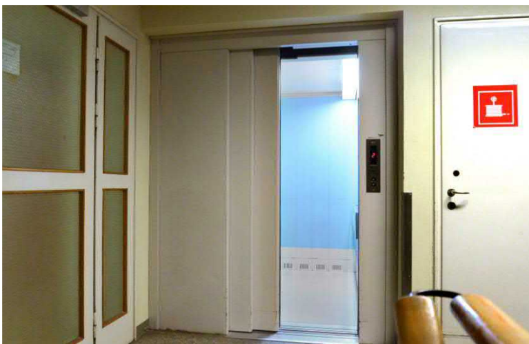
Porrashuoneiden hissit on uusittu 1988.
