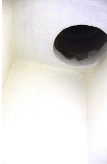
Rikkahuone A-siiven kellarissa. Syvennyksessä on roskakuilu (kuva oikealla). Rikkahuoneen vieressä on ollut vastaavanlainen kuilulla varustettu tila likapyykkiä varten.
