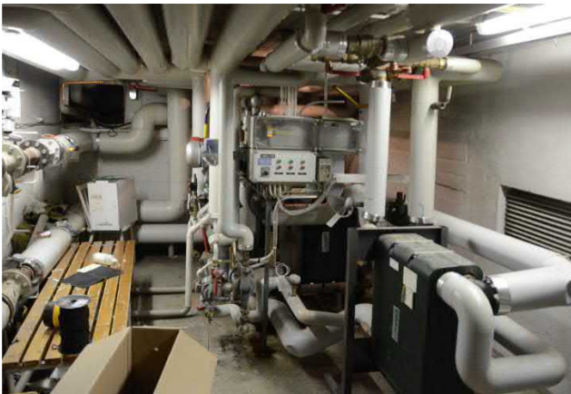
Lämmönjakuhuone entisessä polttoainevarastossa B-rakennuksen kellarissa.
