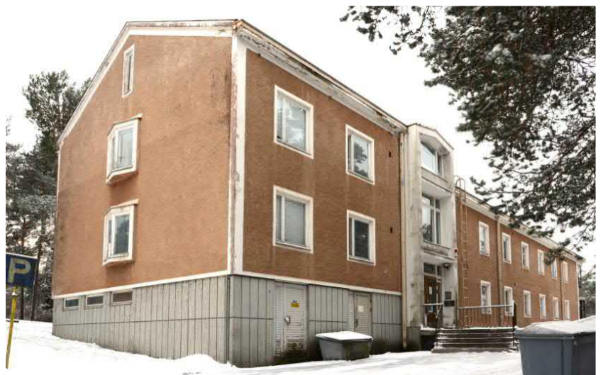
Yllä eteläsivu ja pohjoispääty, keskellä länsipääty, alla pohjoissivu ja itäpääty.
