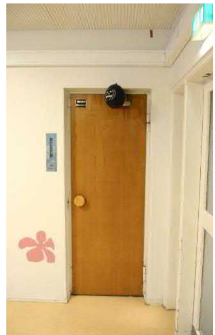
Aulojen puolella olevat pienet henkilökuntahissit on poistettu käytöstä.
