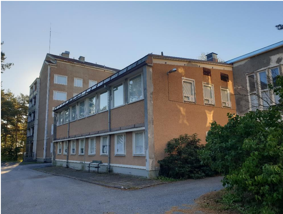
Kuva 3. Rakennus A (takana) ja rakennusten välinen yhdysosa (etualalla).
