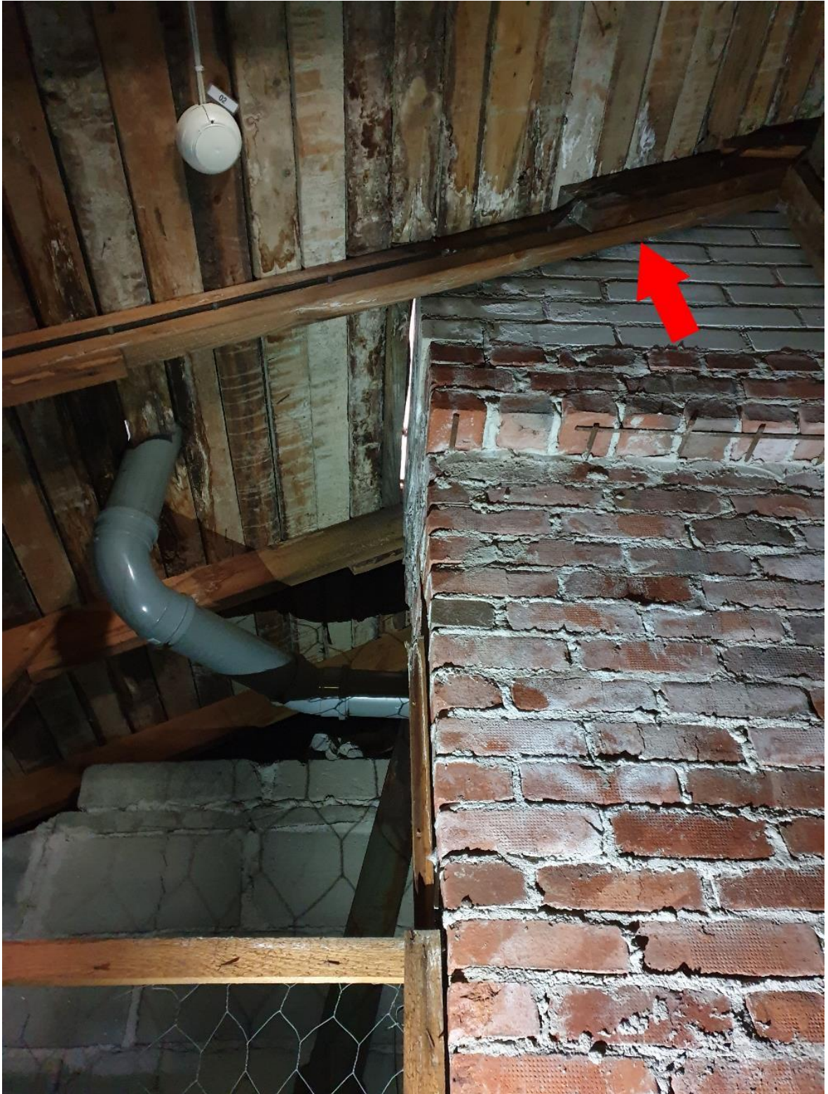
Kuva 9. Rakennuksen A piipun läpivienti kuvattuna sisäpuolelta. Nuolella osoitettu muurin ja kattotuolin välinen rako, joka on lepakoiden oleskelupaikka. Piipun vasemmasta reunasta näkyy päivänvalo; tämä on lepakoiden todennäköinen kulkureitti.
