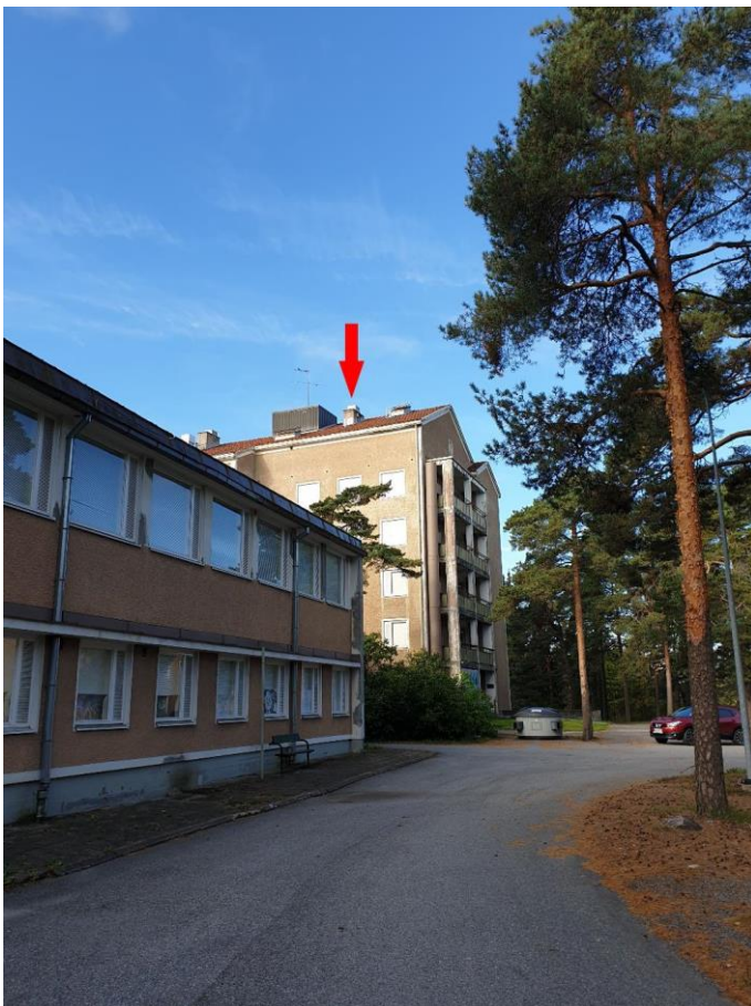
Kuva 4. Rakennus B. Nuolella osoitettu savupiippu, jonka tyvellä on lepakoiden kulkureitti.
