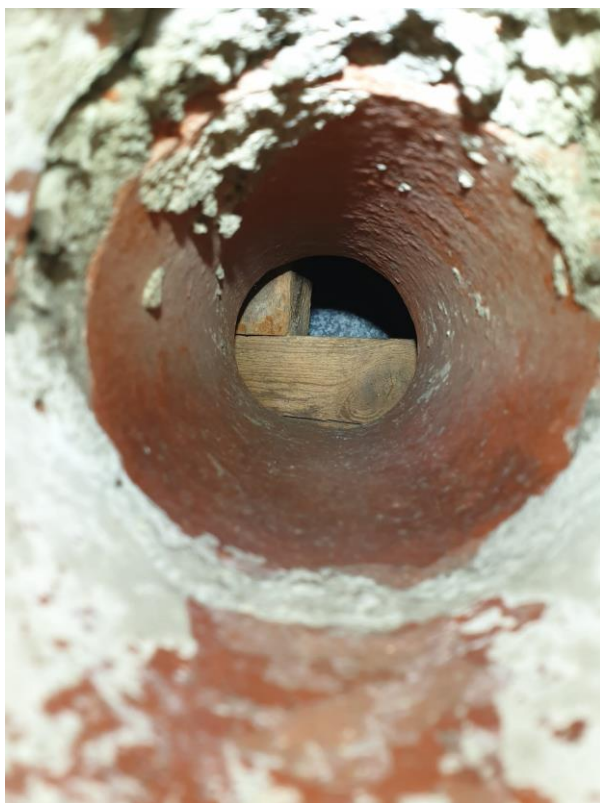
Kuva 13. Matalan yhdysrakennuksen ulkoseinän tuuletusputki.
