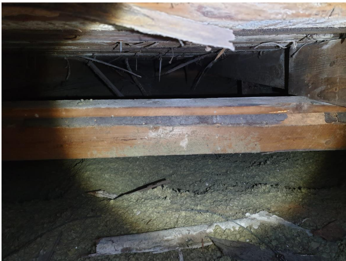
Kuva 12. A- ja B- rakennusten välisen matalan yhdysrakennuksen ullakkotilaa.
