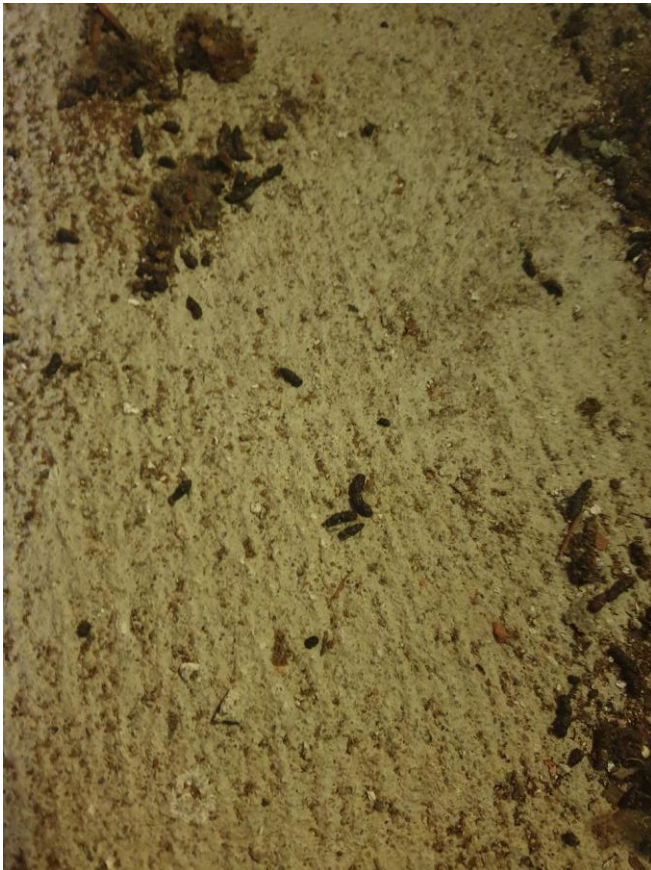
Kuva 11. Papanoita rakennuksen C ullakolla.
