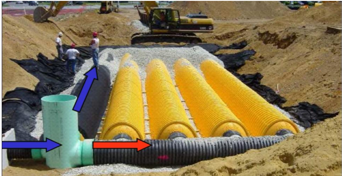
Kuva 20. Maanalainen viivytyksrakenne, jossa myös hulevesien laadun hallintaa 11 .
