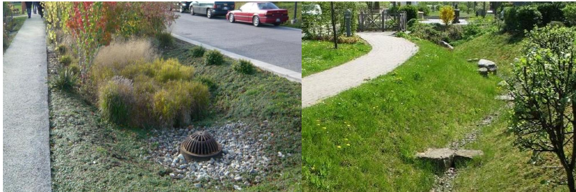
Kuva 22. Esimerkkikuvia viivytys- ja puhdistuspainanteesta katu- tai pysäköintialueen vieressä 9 .
