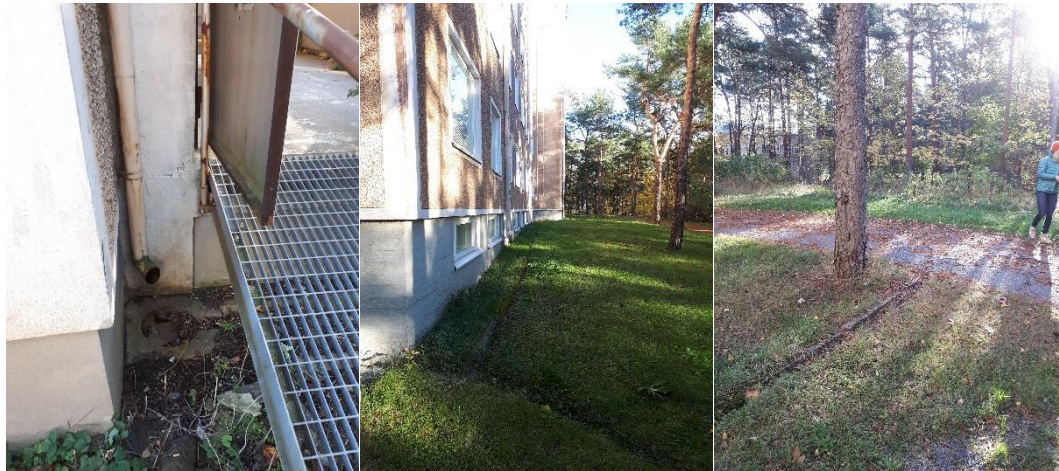
Kuva 5. Nykyiset hulevesien hallintaperusteet. Ylhäällä vasemmalta oikealle: Keskirakennuksen kattovedet on liitetty hulevesiviemäriverkostoon, sivurakennuksien kattovedet on johdettu suoraan pihalle. Alhaalla vasemmalta oikealle: sivurakennuksien kattovedet on johdettu kourujen kautta eteenpäin metsään.
