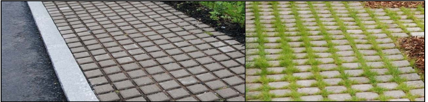
Kuva 7. Esimerkkejä läpäisevistä päällysteistä. Tampere, Vuores. 5
