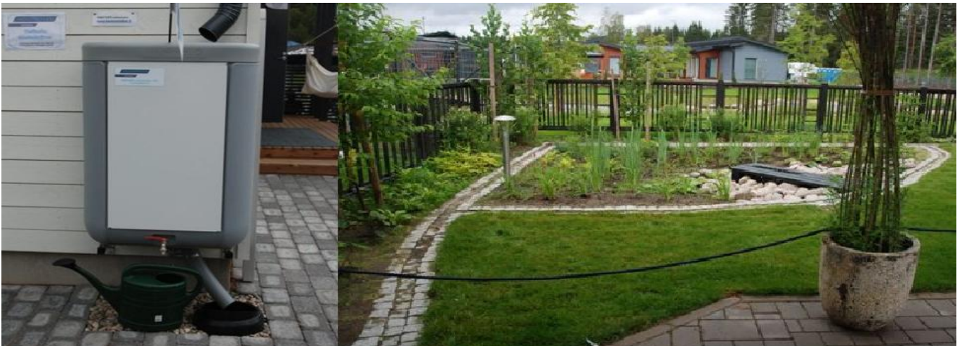
Kuva 9. Vasemalla esimerkki 190 litran kattovesisäiliöstä. Oikealla sadepuutarha, jonne hulevedet johdetaan maanpäällisiä kouruja pitkin. 5
