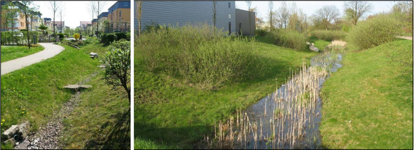
Kuva 11. Vasen kuva: Erosiosuojattu avo-oja, Hannover Saksa. Oikea kuva: Esimerkki viivytyspainanteesta, Hannover Saksa. 5
