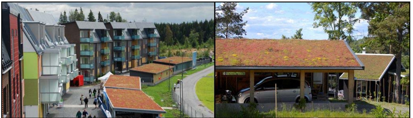
Kuva 8. Viherkattoja autokatoksissa. Vasemmalla Tampere 5 , Vuores ja oikealla Ruotsista, Huskvarna. 7
