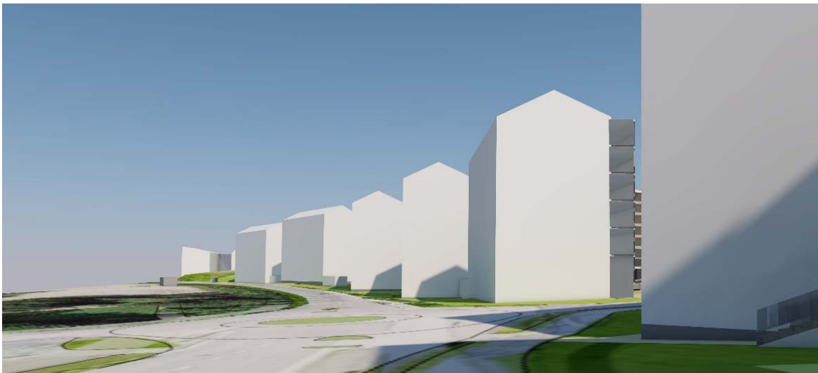
Näkymä Kunnallissairaalan tieltä koilliseen
