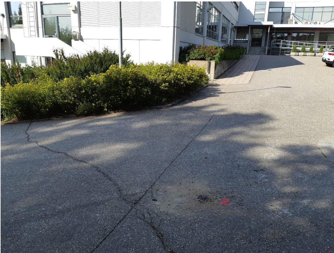
Kuva 1. Näytepiste S2 kuvattuna pohjoiseen, kohti rakennusta
