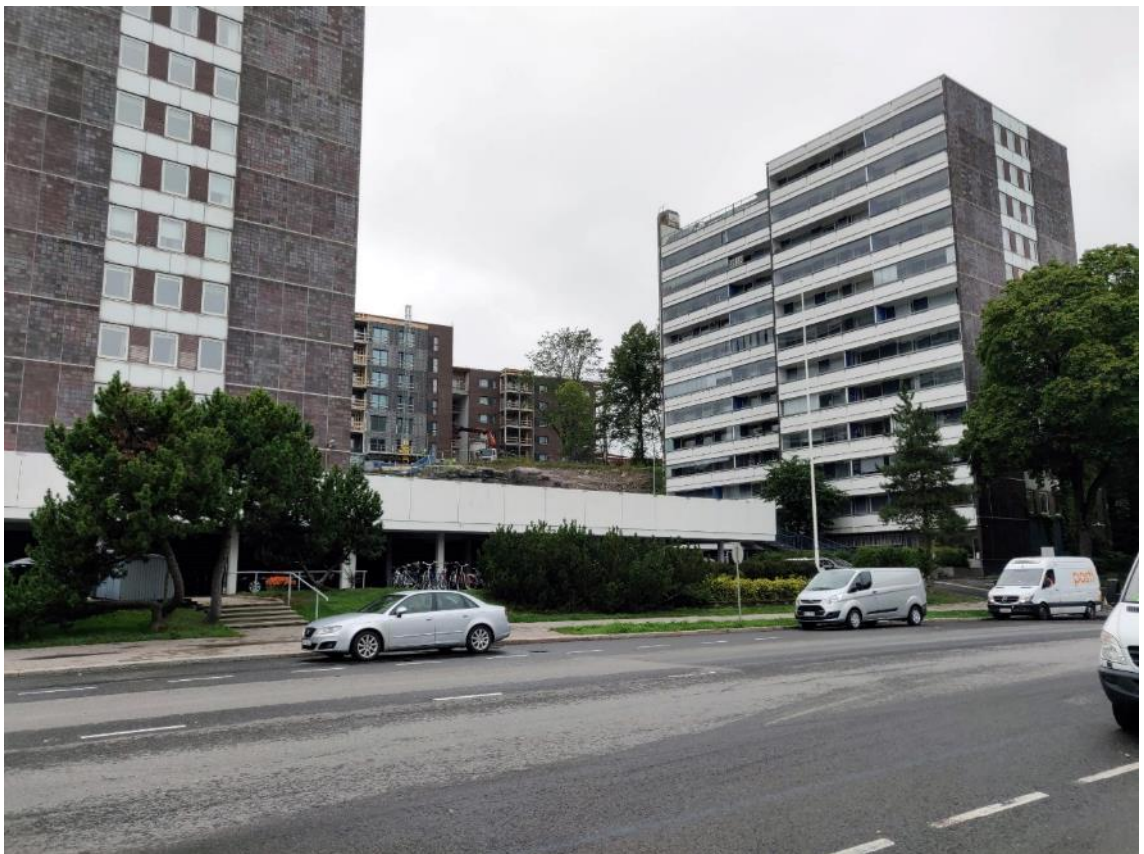
Kuva 5. Kuva kaavoitettavalle alueelle Linnankadulta. Kuvassa keskellä kaava-alueen itäisimmän tontin rakennustyömaa.
