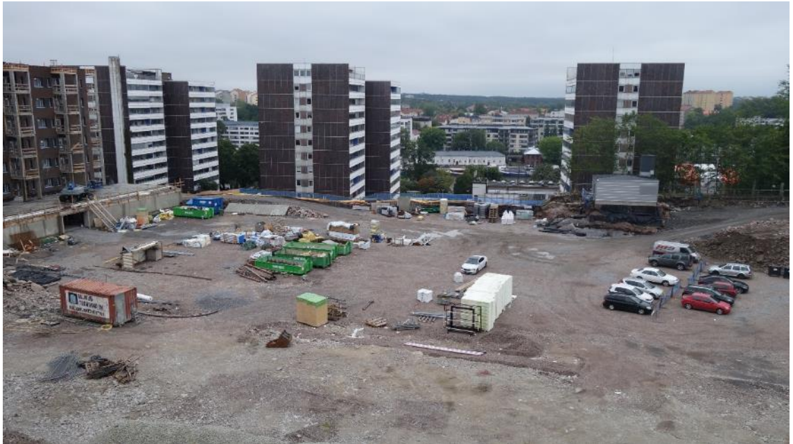
Kuva 4. Kuva kaavoitettavalle alueelle syksyllä 2019. Kuvassa vasemmalla kaava-alueen itäisimmän tontin rakennustyömaa.
