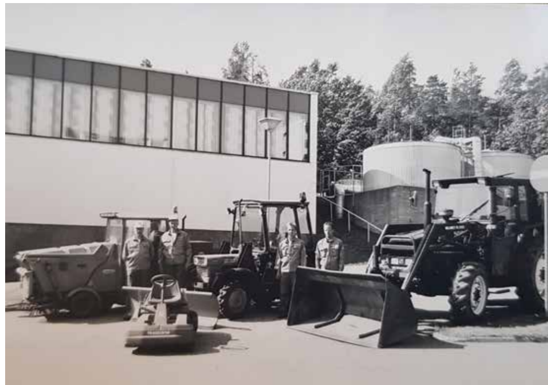
Hepokullan lämmön huoltokalustoa lämpökeskuksen edustalla. Kuva Hepokullan Lämpö, arkisto.
