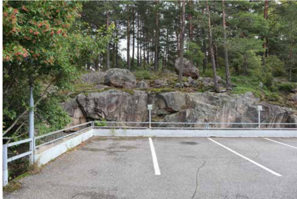
Varkkavuorenkadun pysäköintitalon yläkansi rajautuu kalliroleikkaukseen.
