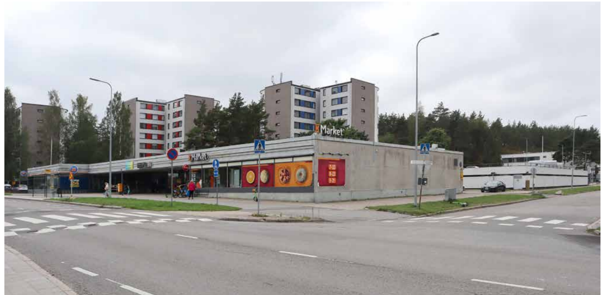
Ostoskeskus Varkkavuorenkadun reunalla. Taustalla oikealla näkyy pysäköintitalo ja Lämpökeskuksen rakennus.
