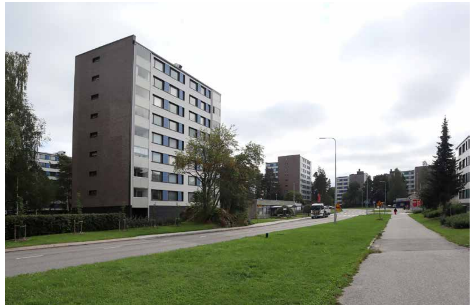
As Oy Varkka-ahon pistetalot reunustavat Varkkavuorenkatua. Taustalla näkyy As Oy Varkkavuoren, Varkkakulman ja Varkkametsän pistetaloja.
