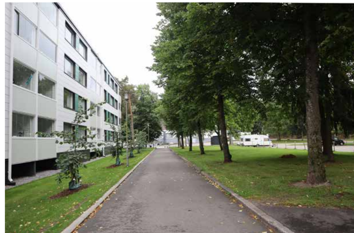
Näkymä Ruohomäenpolulta, taustalla lämpökeskuksen rakennus.
