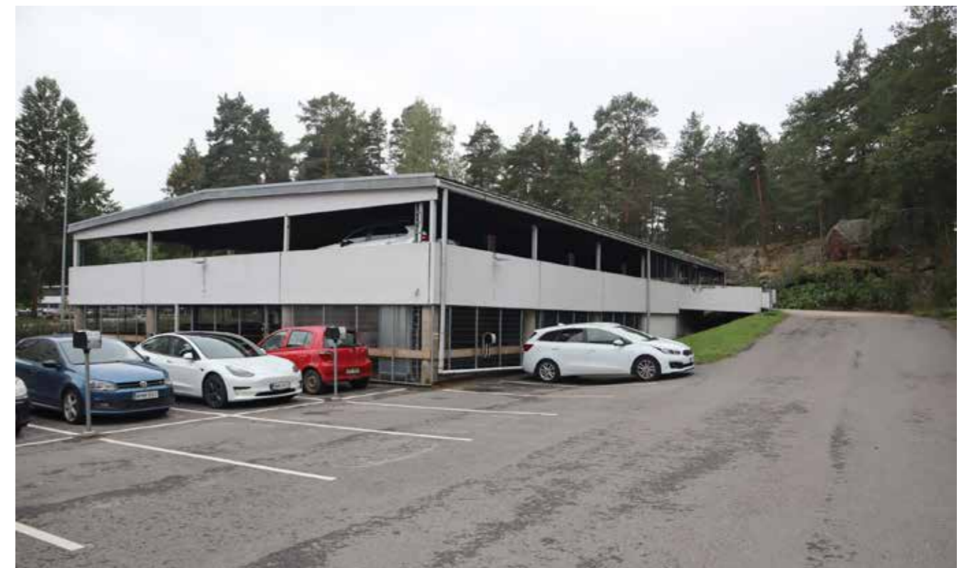
As Oy Jahtilähteen pysäköintitalo on sovitettu maastoon hyödyntäen rinnettä toiseen kerrokseen johtavana tienä.
