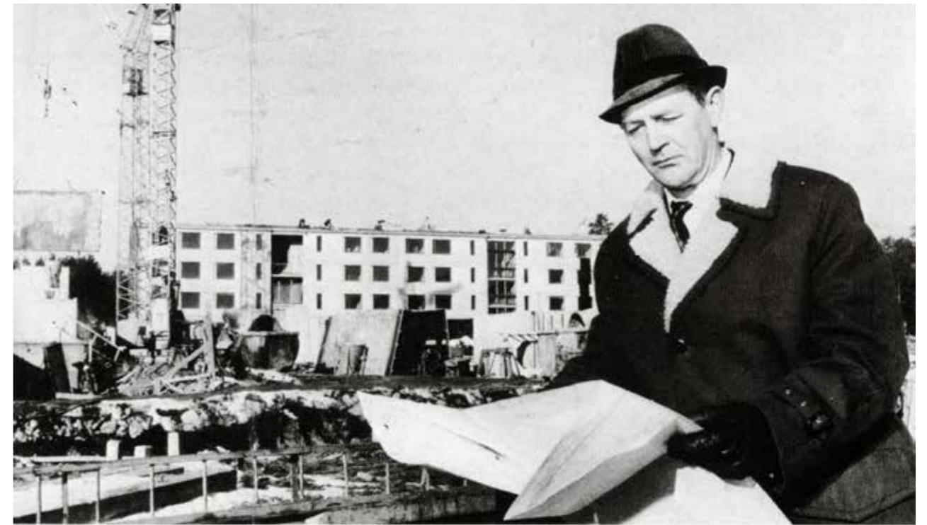
Hepokullan alueen vastuunalaisena työjohtajana toiminut rakennusmestari Antti Kosola. Kuva Turun lähiöt
