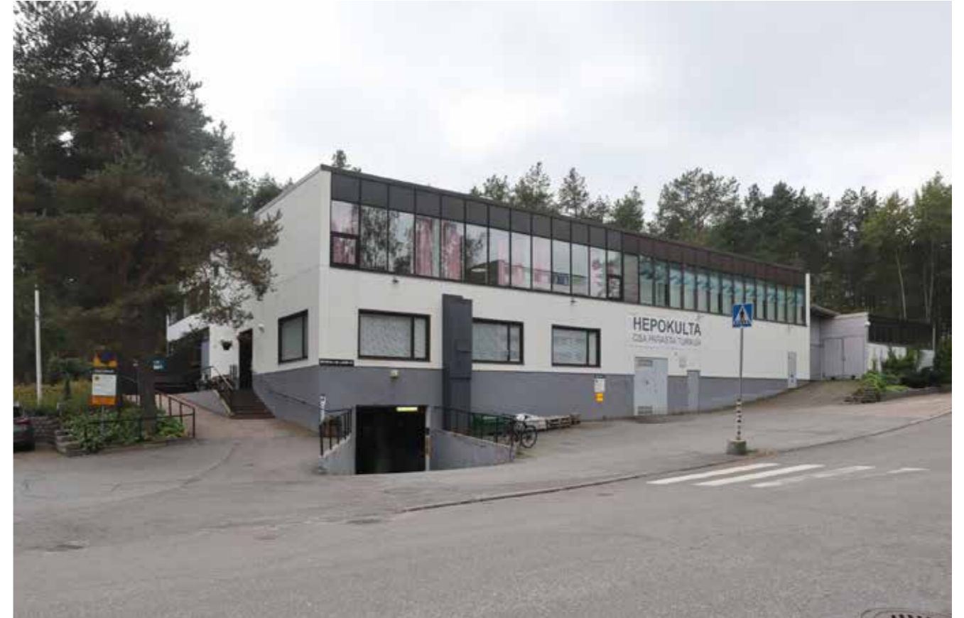
Lämpökeskuksen rakennus on pääpiirteittäin säilyttänyt alkuperäisen ilmeensä. Nykyään rakennus toimii alueen kokoontumistilana, sekä isännöinnin ja huollon toimipisteenä.
