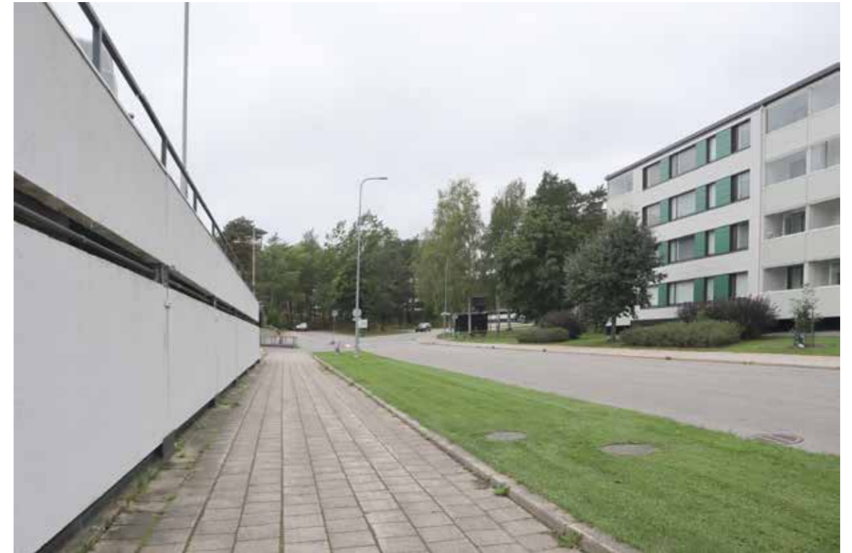
Jahtilähteenkadun pysäköintitalo muodostaa kadun varressa pitkää suljettua seinää.
