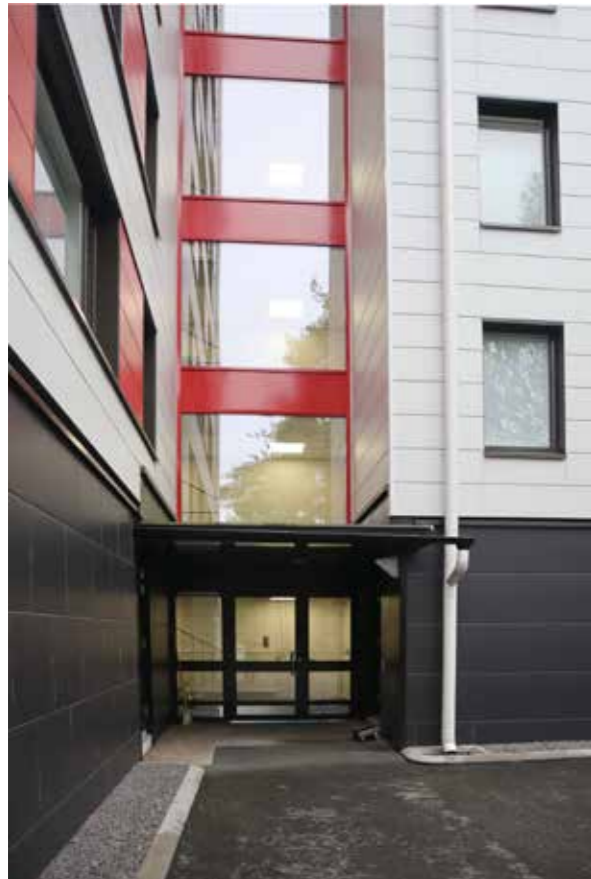
Sisäänkäynti ja sen päällä kohoava porrashuoneen lasiseinä sijoittuvat rakennuksen sisäkulmaan. As Oy Jahtilähteen tehostesävynä on punainen.
