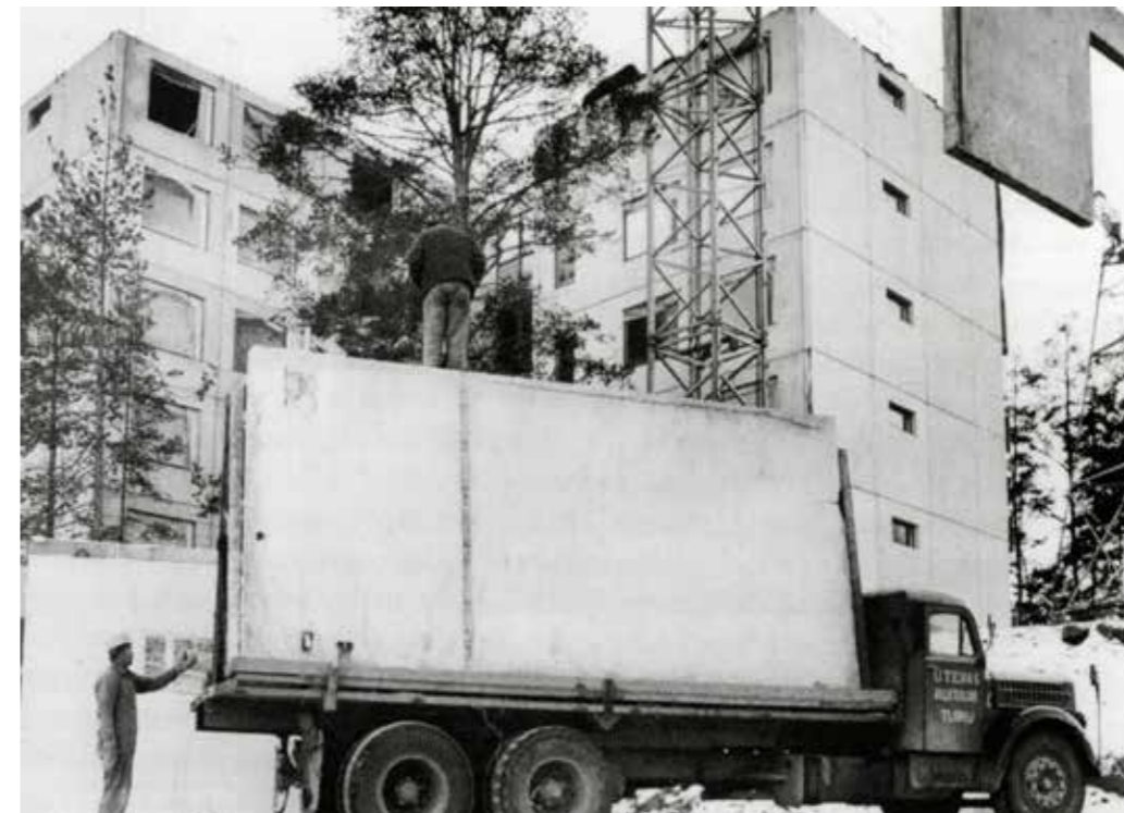
Betonielementit pyrittiin nostamaan suoraan kuorma-auton lavalta paikoilleen, jolloin välttyttiin välivarastoinnilta. Tehokkaasta rakentamistavasta huolimatta pyrittiin puustoa säilyttämään myös aivan rakennusten vierellä. Kuva Turun lähiöt.
