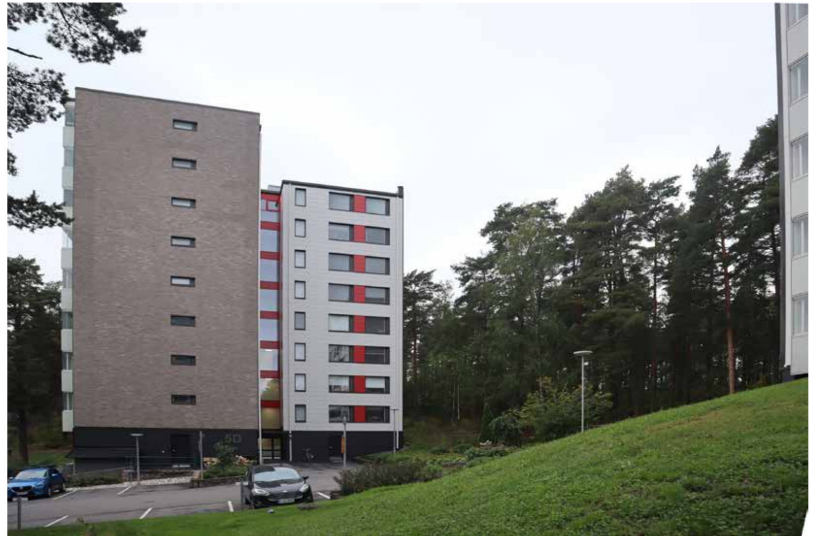
Rakennukset sijoittuvat kumpuilevan maaston lomaan. Materiaalivaihdos ja massoittelu tuo keveyttä suureen rakennukseen. Kuva As Oy Jahtilähteen pihasta.
