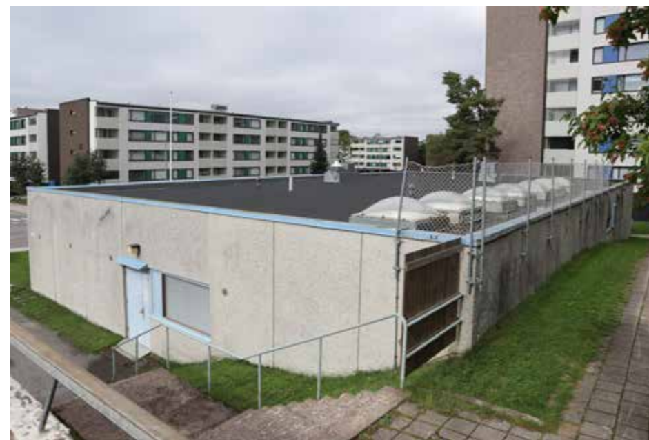
Pääsy rakennuksen katolle on estetty verkoin.
