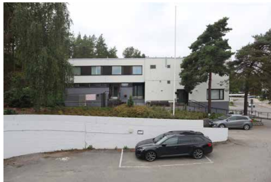
Sisäänkäynti toimistotiloihin ja edelleen juhlasaliin on rakennuksen itäpäädyssä.
