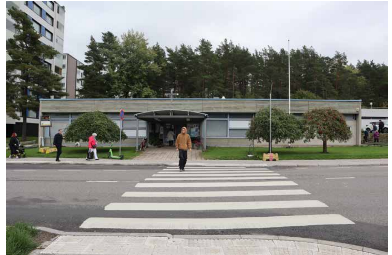
Rakennus erottuu Varkkavuorenkadun kaupunkikuvassa puuverhoillun julkisivunsa sekä ulkonevan katoksen ansiosta.
