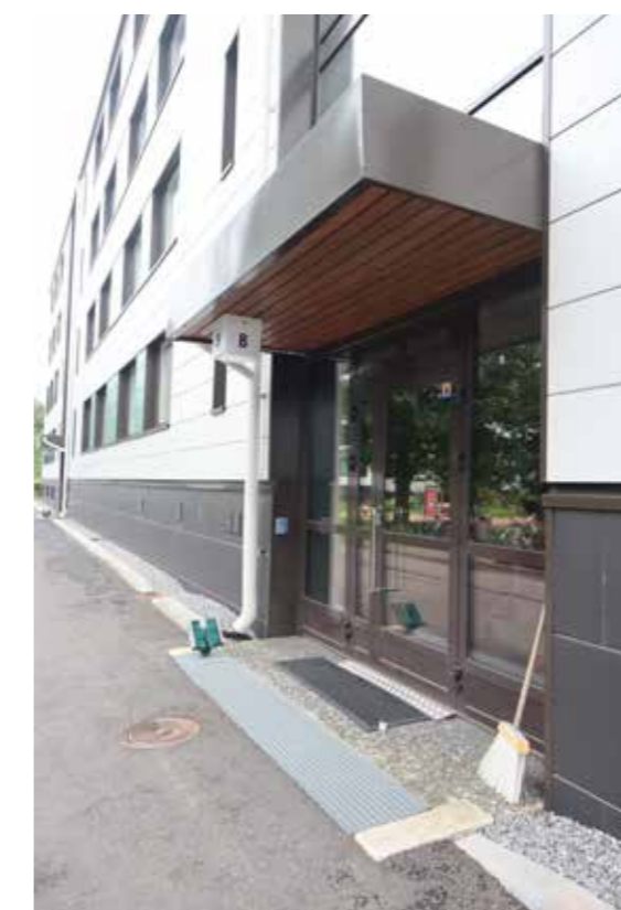
Sisäänkäynti on muutettu esteettömäksi korottamalla maanpintaa porrastasanteen tasoon. Katos, ulko-ovet ja porrashuoneen ikkunaseinä on uusittu.
