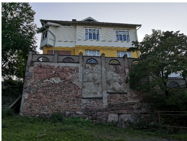
Kuva 26. As Oy Samppalinnan muuri
