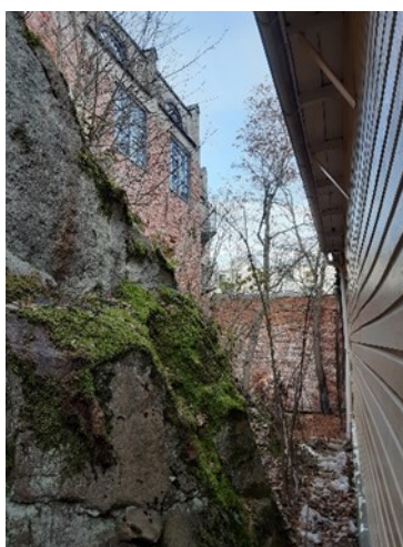
Kuva 8. Ikkunat naapurin muurissa
