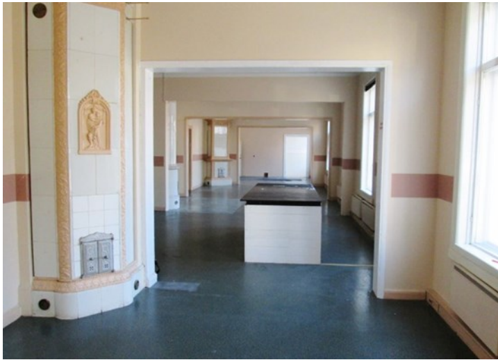
Kuva 22. Rakennus 1, 1. kerros, kadun puoleiset salit
