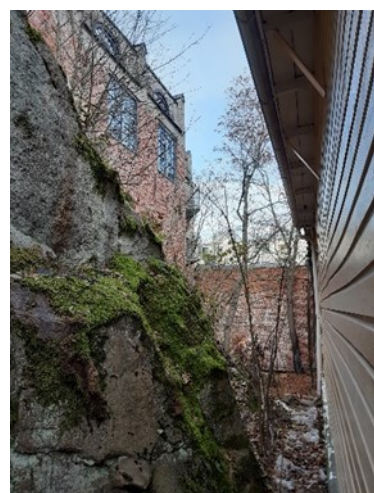
Kuva 8. Ikkunat naapurin muurissa
