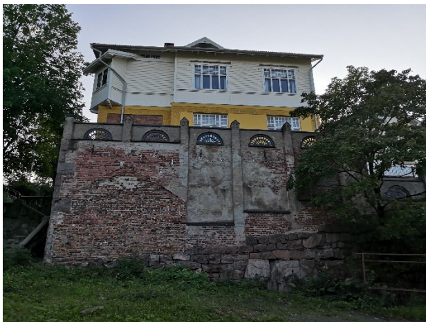
Kuva 26. As Oy Samppalinnan muuri
