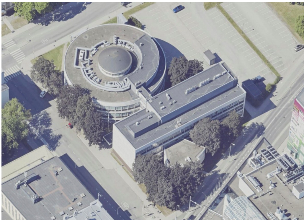
Kuva 18. Myöhemmin lisättyjä IV-rakenteita Dentalian katolla. Pyöreän A-osan keskellä näkyy kupolikattoinen yläikkuna. © Turun kaupunki
