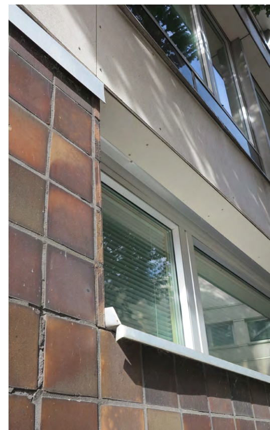
1.krs ikkunan yksistysikohta B-osassa.
