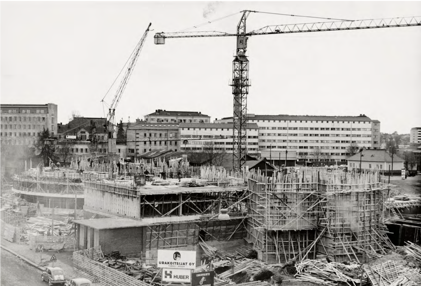
Laitoksen työmaa vuonna 1966, edustalla näkyy viuhkamaisen luentosalin muottirakenteita. Valokuvaaja Rautavuori. Museovirasto Journalistinen kuva-arkisto JOKA
