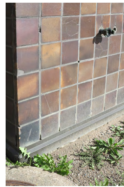
Sokkelin alareunassa näkyy patolevy.
