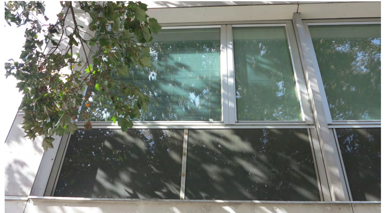
Julkisivuelementti B-osalla. ikkunat on uusittu vuoden 29005 korjauksen yhteydessä mutta värilasi on alkuperäinen.
