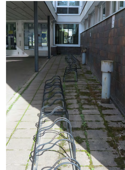
Sisäänkäynnin yksityiskohtia. Katos on myöhemmin uusittu.
