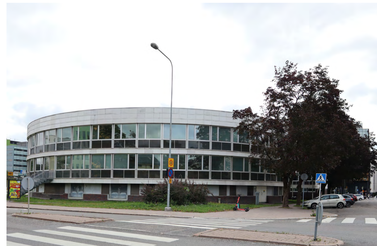
Näkymä Lemminkäisenkadun puolelta vuonna 1966 (kuva TY:n arkisto) ja nykytilanteessa. Vähäisenä muutoksena näkyvät pohjakerrokseen lisätyt aiemmin yhtenäisenä jatkunutta sokkelilinjaa katkaisevat ovet, sekä suureen mittaan kasvaneet rakennuksen julkisivusävyjä toistavat vaahterat.
