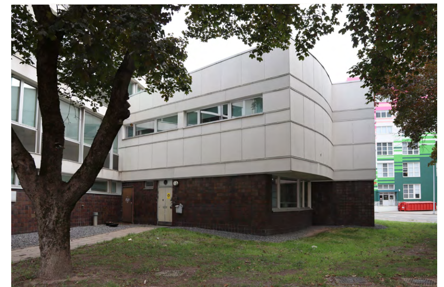
Luentosalin viuhkamaisesti muotoiltu siipiosa on monelle opetusrakennukselle tunnusomainen pitkää julkisivua katkaiseva yksityiskohta. Pohjakerroksessa salin alla sijaitsi alkujaan vahtimestarin asunto.
