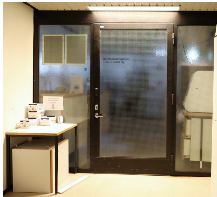
Palo-osastoja erottavat käytävän kohdalla lankalasi-seinät lasiovineen.
