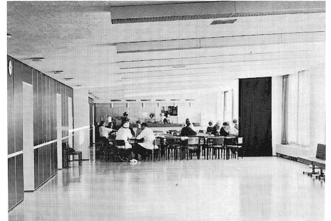
Pääaula ja ruokasali, nykyinen kahvila 208 ja aula 206 B-osan 2. kerroksessa. Kuva esite/AM.
