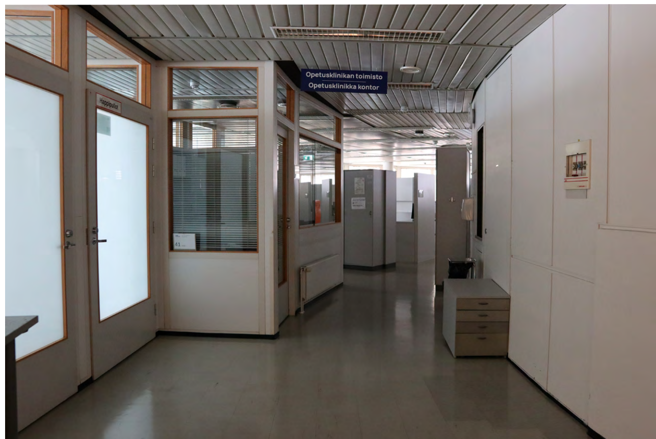
Käytävään kantautuu luonnonvaloa yläikkunoiden kautta. Alakatto jatkuu yhtenäisenä käytävästä huonetiloihin.
