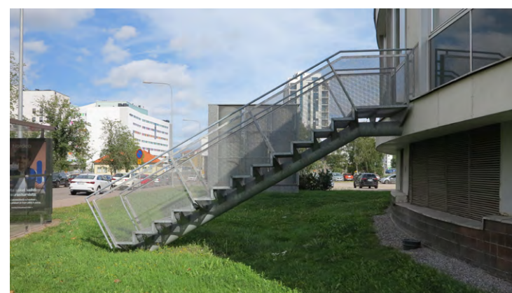
A-osan toisesta kerroksesta johtava avoin positimistieporras on alkuperäinen yksityiskohta. Portaen kaiteet ja mahdollisesti myös muu osa on myöhemmin uusittu.
