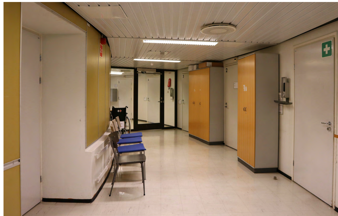
Ovet rungon keskiosaa kiertäviin aputiloihin sijoit-tuvat sisäänvedettyinä asennusseinän takalin-jaan. Käytävän varteen on sijoitettu irtokaappeja.
