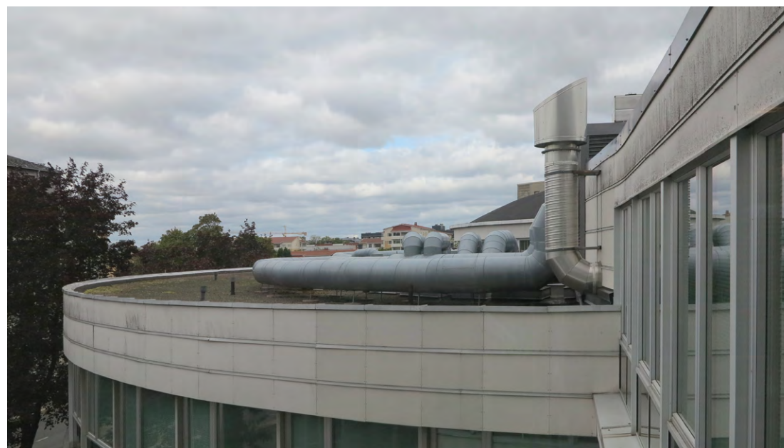
Näkymä B-osan 4. kerroksesta. Yläpohjan kohdalla mineritverhous on vaakasuunnassa jaettu välipohjan levytyksen korkeutta vastaavaan kolmeen osaan.
