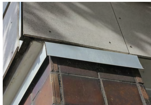
Mineritverhouksen ja laattapintaisen pohjakerroksen liittymä B-osan etelänurkalla.
