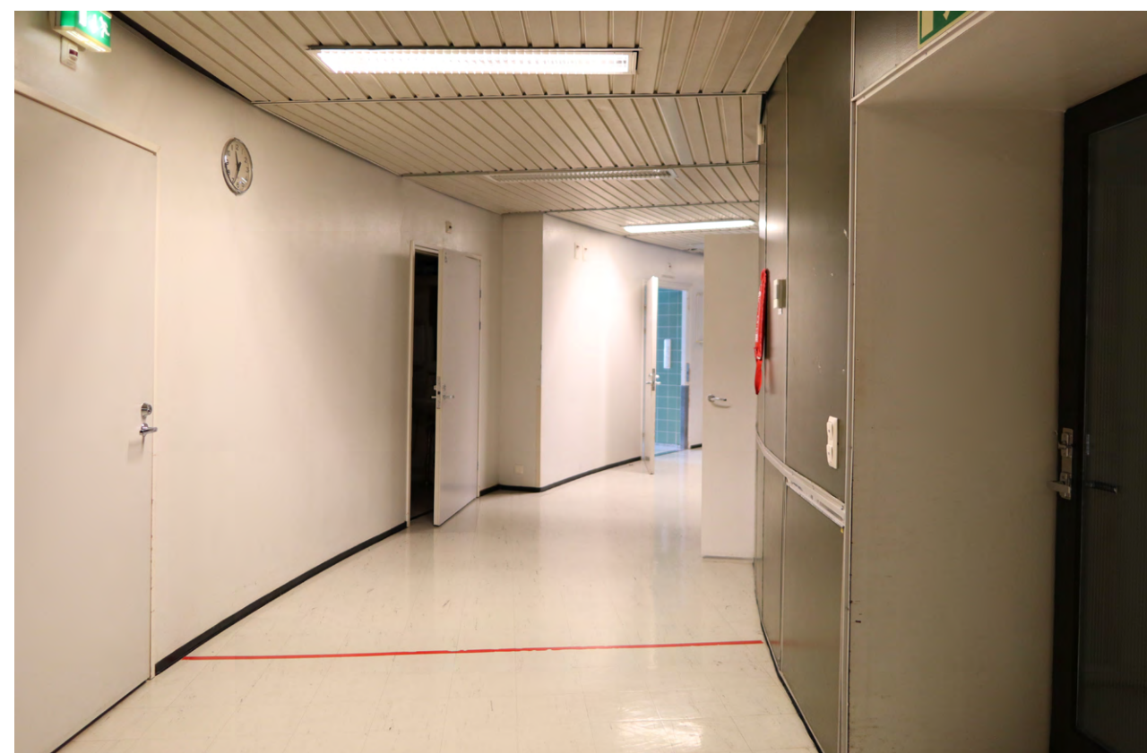
Käytävän sisäreunassa sijaitseva asennusvyöhyke erottuu syvinä ovismyygeinä.
