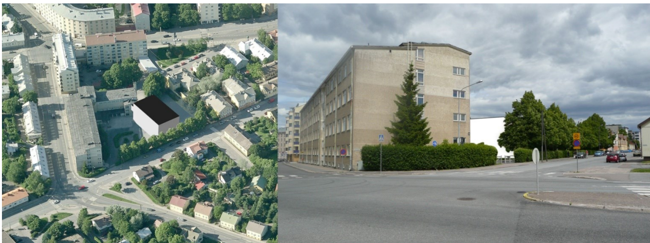
Havainnekuvia siitä, miten lisärakentaminen voisi sijoittua tontille ja joka tapauksessa kaupunkikuvallisesti taka-alalle jäävänä
