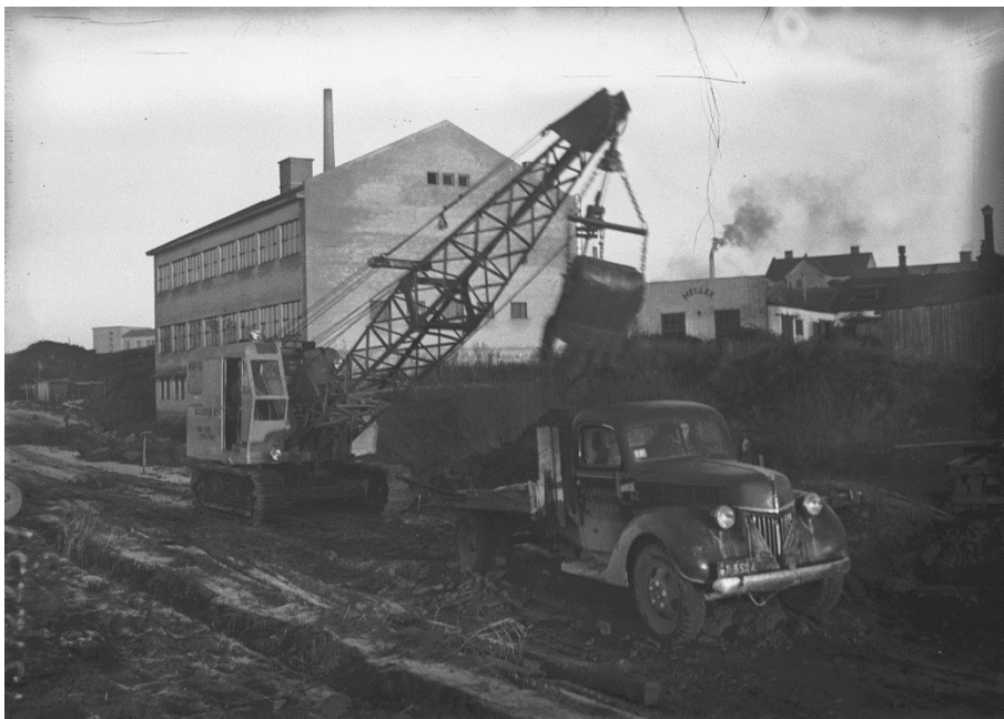
Kaivinkone Halisten vehnämyllyn ja Kupittaan rautatieaseman välille rakennettavan rautatien työmaalla. TS 28.11.1948.
