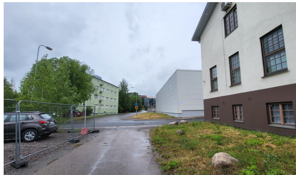
Näkymät idästä länteen päin. Rautakatu 5 ja 6 vanhat rakennukset muodostavat yhdessä 1940-luvun ympäristöä. Taustalla Kupittaaan uudempia toimistotaloja.
