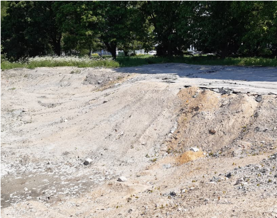
Kuva 1. Täyttömaapohjaa saven päällä
