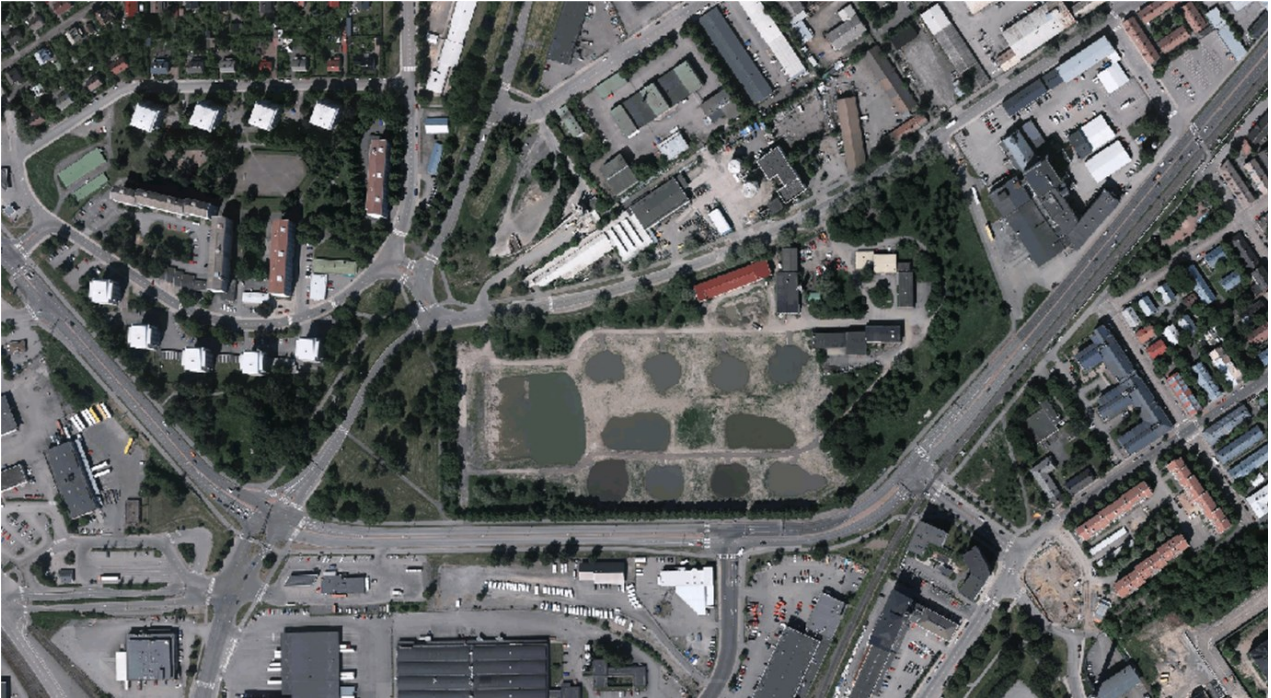
Kuva 27 Puhdistamorakennukset ovat edelleen tontilla lukuun ottamatta purettuja puhdistamoaltaita. Kuva: Terratec Oy
