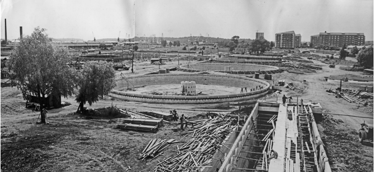
Kuva 8 Jätevedenpuhdistamon rakentaminen vuonna 1965. Kuva: Turun museokeskus
