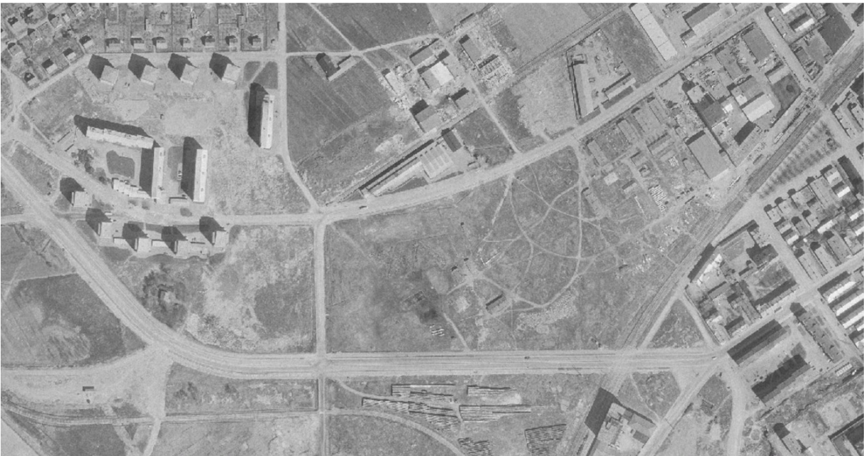
Kuva 22 Parakit siirtyivät puolustusvoimilta vuonna 1952 Turun kaupungin omistukseen. Huonosta kunnosta huolimatta niissä on asuintoimintaa suuresta asuntopulasta johtuen. 1960 viimeinenkin parakki purettiin. Kuva: Blom Kartta Oy, Maanmittauslaitos
