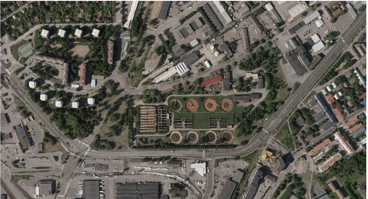
Kuva 26 Vedenpuhdistamo lopetti toimintansa joulukuussa 2008 Kakolanmäen maanalaisen jätevedenpuhdistamon valmistuttua. Kuva: Blom Kartta Oy, Maanmittauslaitos
