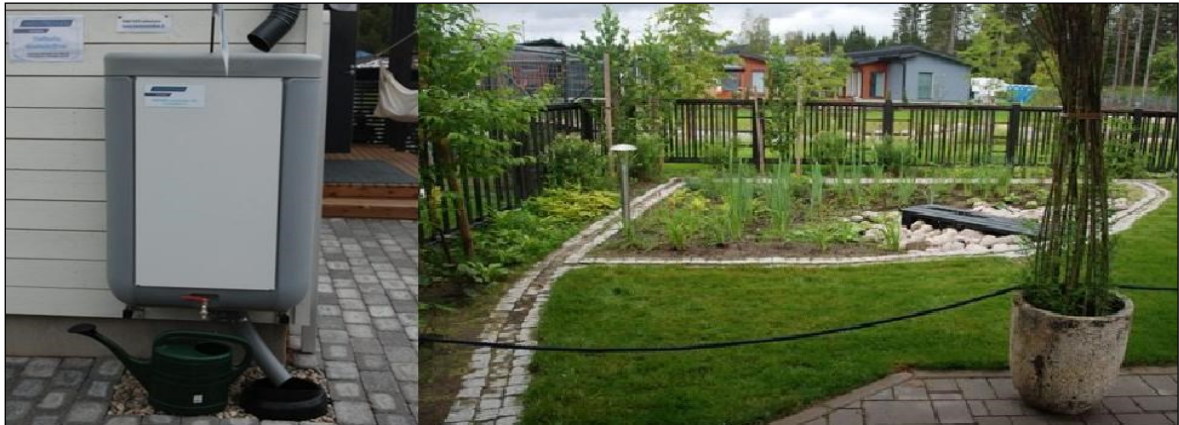
Kuva 26. Vasemmalla esimerkki 190 litran kattovesisäiliöstä. Oikealla sadepuutarha, jonne hulevedet johdetaan maanpäällisiä kouruja pitkin 11 .
