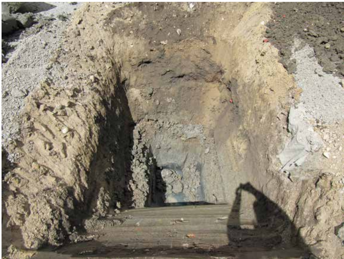
Mutu117021Dg_11. Koekuoppa RF30 pohjaan kaivettuna. Lounaasta. J. Haarala.
