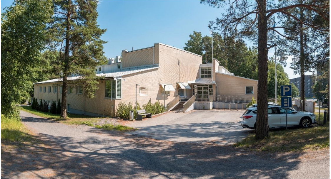
Kuva 5. Sorakadun varren toimistorakennus vuodelta 1991. © Turun kaupunki (kuva: Jukka Koskelainen)
