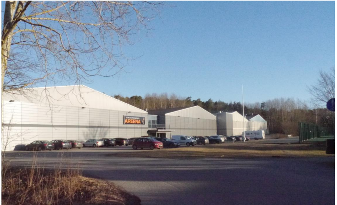
Kuva 2: Vaiheittain rakentunut tenniskeskus maaliskuun aamuna 2017
