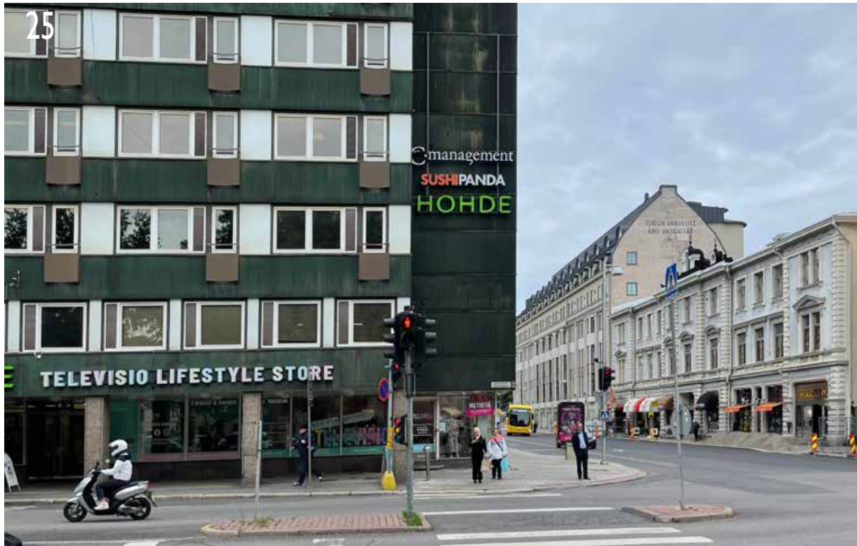
25 Linnankadun varrella jalkakäytävä kulkee Kuparitalon arkadikäytävän alla. Kuva elokuulta 2022.
