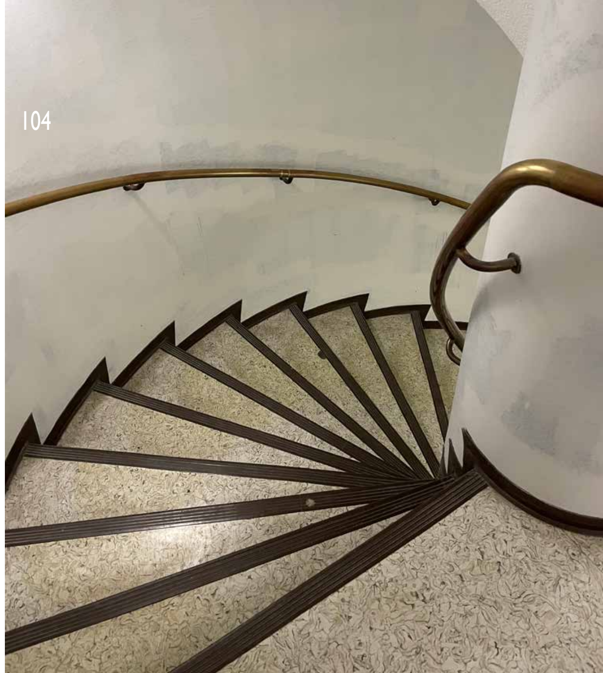
104 Pankkisalisiin johtava portaitko ja sen käsijohde ovat alkuperäisestä rakennusvaiheesta. Kuva elokuulta 2022.
