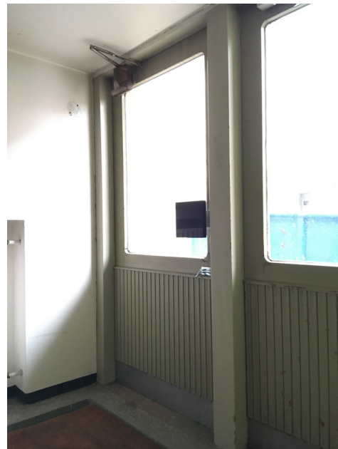
Vasemmalla ja alla toisen laajennuksen ulko-ovet Luostarinkadulle.
