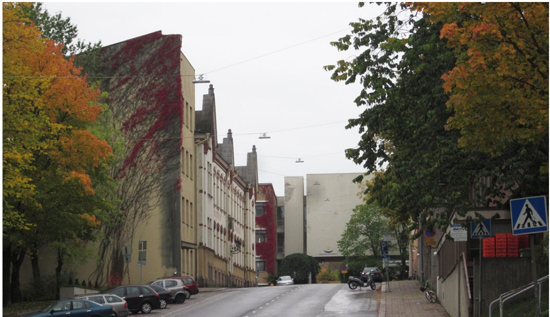
Kuva 7. Teollisuuskoulun vuosina 1945-47 rakennettu laajennus Luostarinkadulla. Vuonna 2014 rakennuksen julkisivulla kasvoi vielä villiviini.
