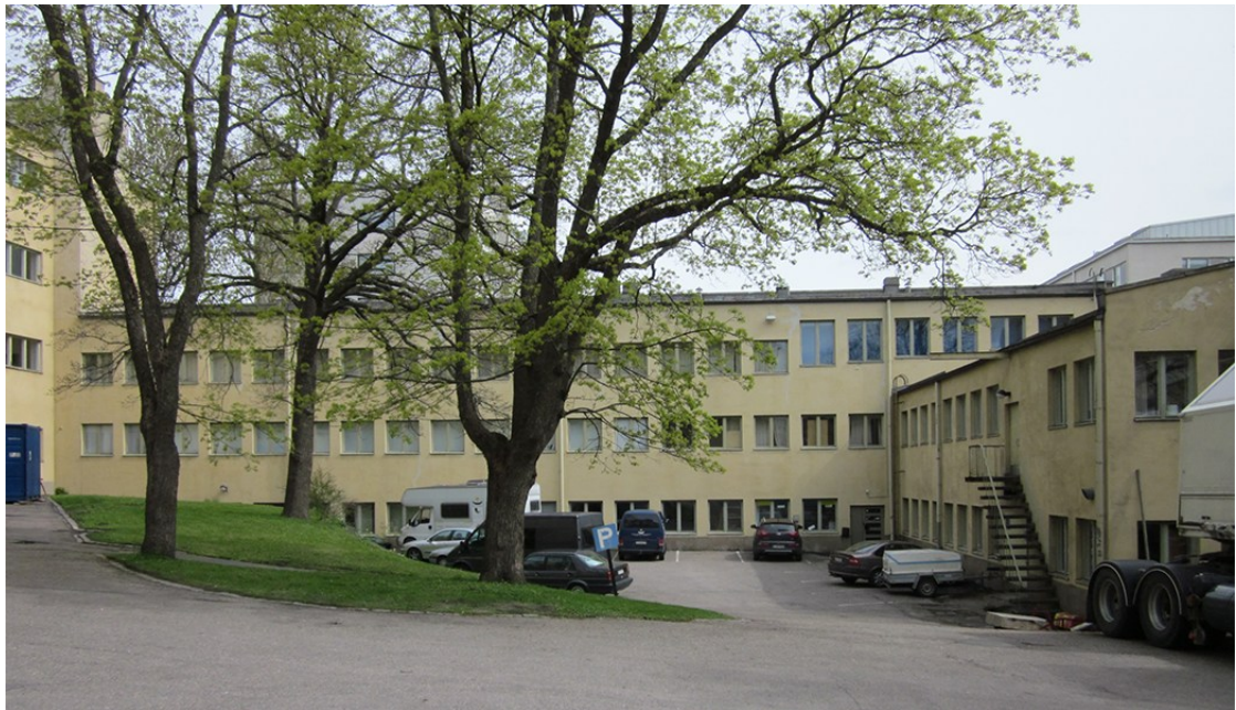
Kuva 8. Teollisuuskoulun vuosina 1945-47 rakennettu laajennus sisäpihan puolella.
