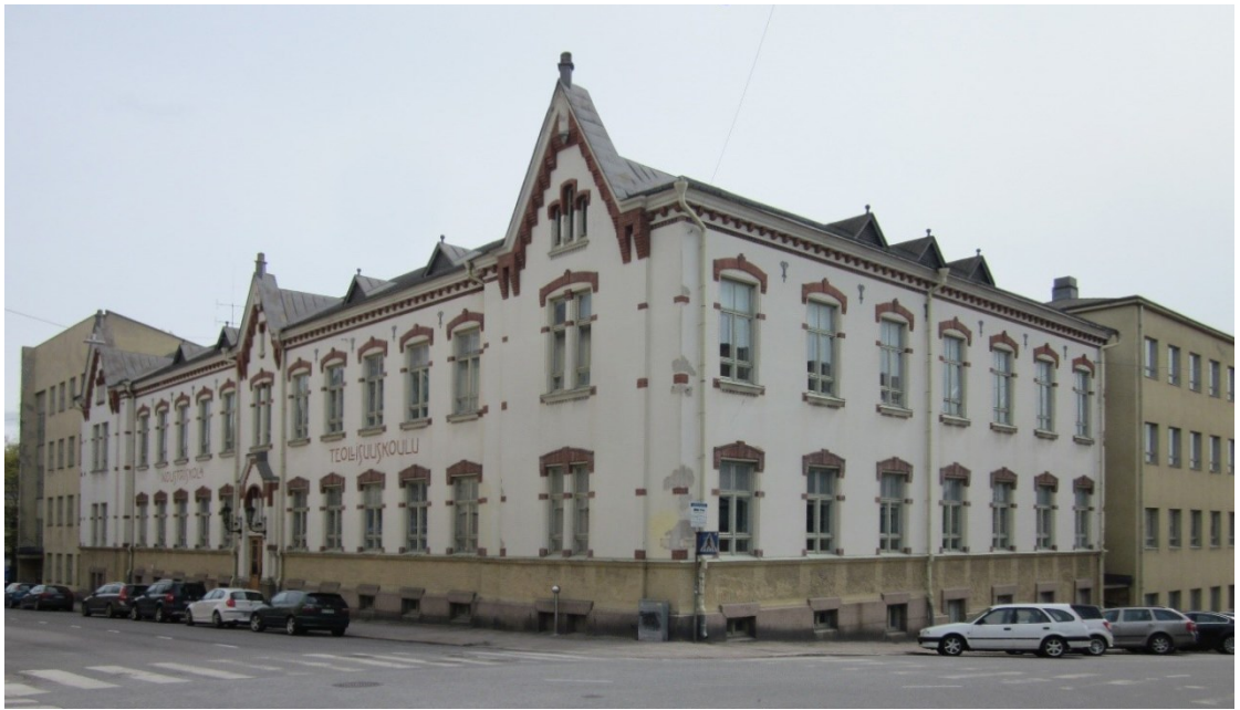
Kuva 5. Teollisuuskoulun vuosina 1899-1903 rakennettu vanhin osa Luostarinkadun ja Sepänpätkadun risteyksessä.
