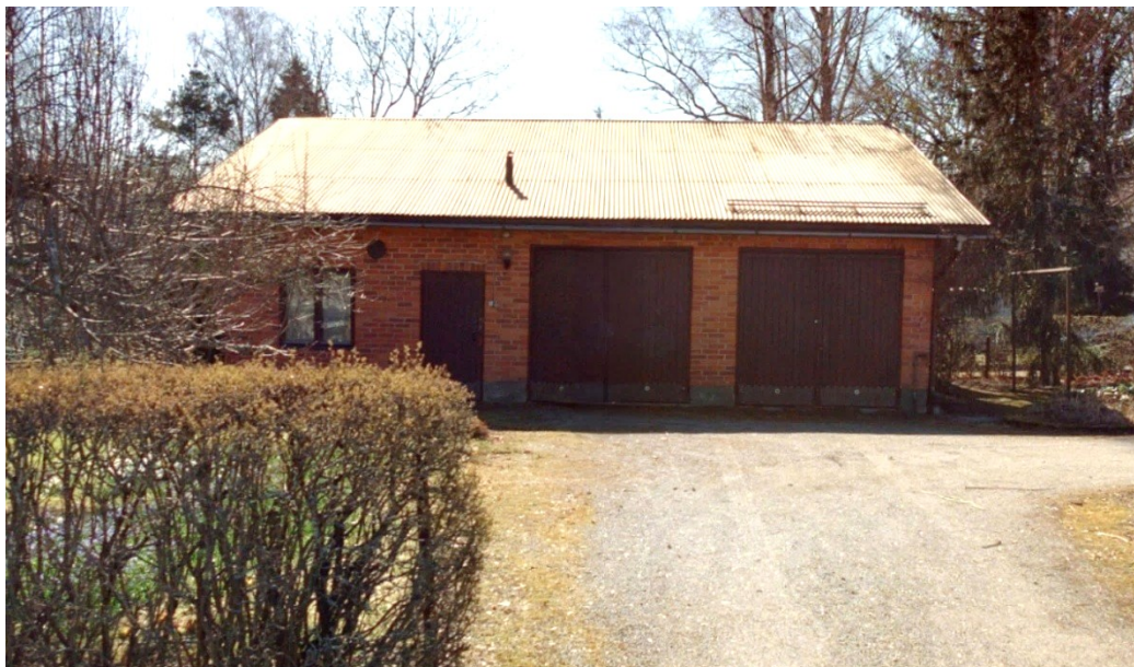
Kuva 4. Vuoden 2024 katunäkymäkuva Keskitalonkadulta tontille 1. Tontilla sijaitsee 1958 valmistunut tiilijulkisivuinen talousrakennus. © Turun kaupunki
