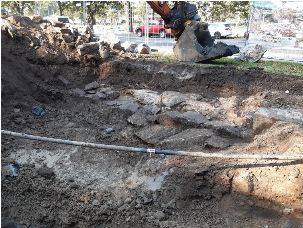
Kuva 3. Vanhan rakennuksen perustukset kaivannossa K2/2
