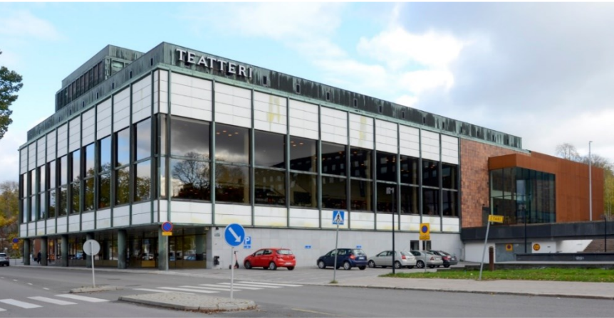
Sisäänkäynti ja lämpiö kadun puolelta kuvattuna. Lämpioosan julkisivuihin ei tehty muutoksia peruskorjauksessa. Ruostutulla teräksellä verhoiltu laajennusosa näkyy oikealla teatterin takana.
