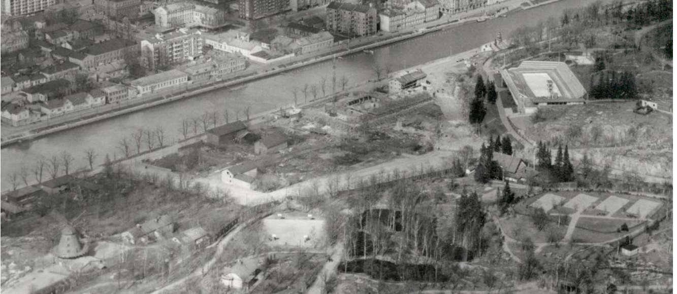
Ilmakuva n. 1960–1961 (KYTO). Teatterin rakennustöiden käynnistyessä osa Makasiinikorttelien rakennuksista oli vielä pysyissä. Tulevalla Aleksis Kiven aukiolla oleva, aiemmin asuinrakennukseksi muutettu Rettigin makasiini oli työmaan käytössä.
