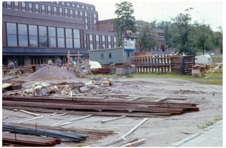
Virastotalon rakennustyömaa 1967 (KYTO).
