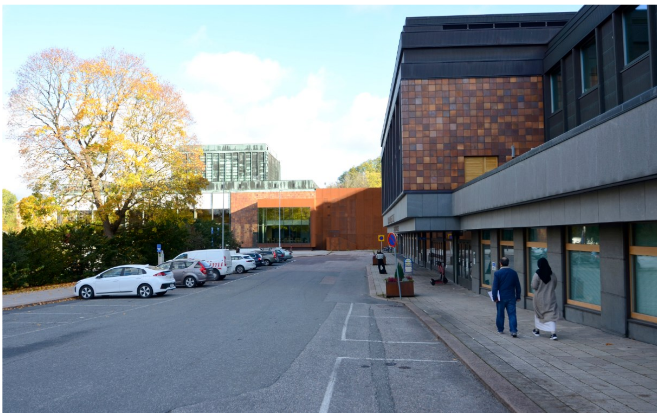
Viraston sisäänkäynti. Auditorio-osa työnnyt ulokkeena ulko-ovien katokseksi. Rakennuksen ja Itsenäisyydenaukion väliin jää entinen Aittakatu paikoitusta ja saattoliikennettä palvelevana piha-alueena. Katulinjan päätteessä on teatterin laajennusosa.
