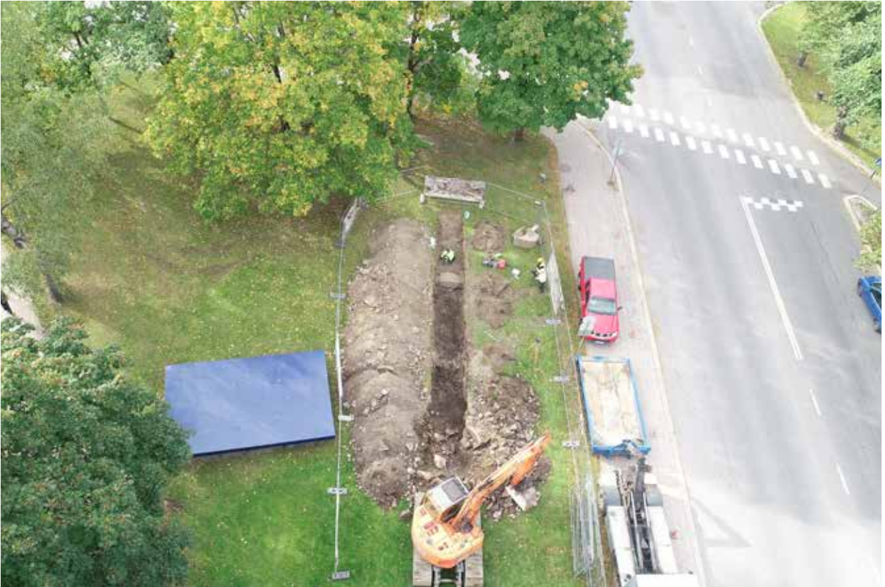
DT2020:24:5: Ilmakuva. Kuoppa 1. Kuopan ensiksi kaivettu koeoja. M102 kaivettu pois, esillä sekalainen/likainen savi M103./ Koillisesta, 22.9.2020, J. Haarala
