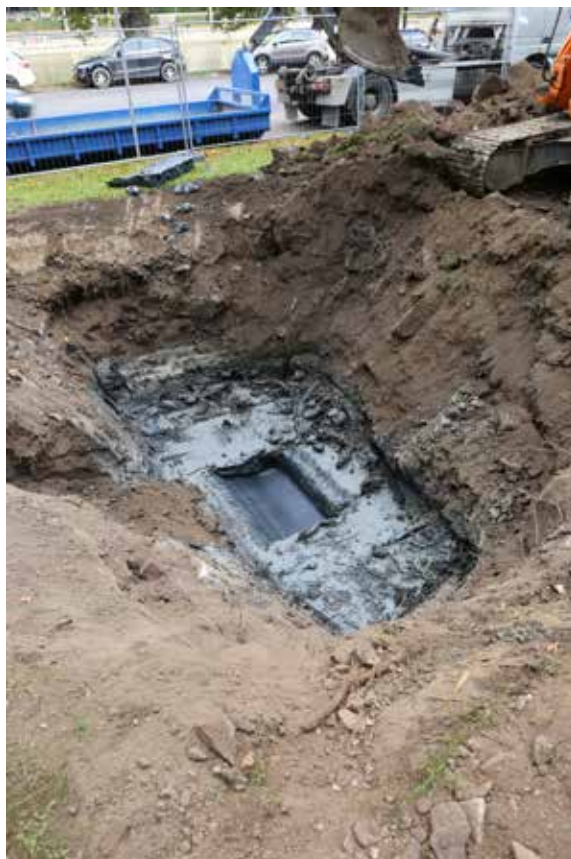
DT2020:24:8: Kuoppa 1. Kuopan laajennus. M104 savi kaivettu pois, esillä harmaa pohjasavi M105 ja keskellä olevassa testikuopassa musta pohjasavi M106./ Etelästä, 23.9.2020, J. Haarala
