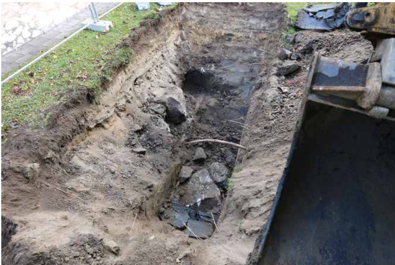
DT2020:24:18: Kuoppa 3. Arinahirret R305 esille otettuina. Kivet koeojan pohjalla on pois paikaltaan irroitettuja R302:n kiviä./ Lounaasta, 25.9.2020, J. Haarala
