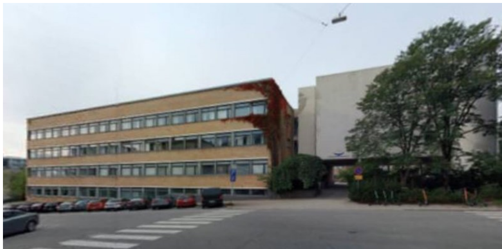
Kuva 4. Näkymä kohti Turun ammattikorkeakoulun rakennuksia Luostarivuorenkadun ja Sepänkadun kulmasta, 2019. © Blom Kartta Oy
