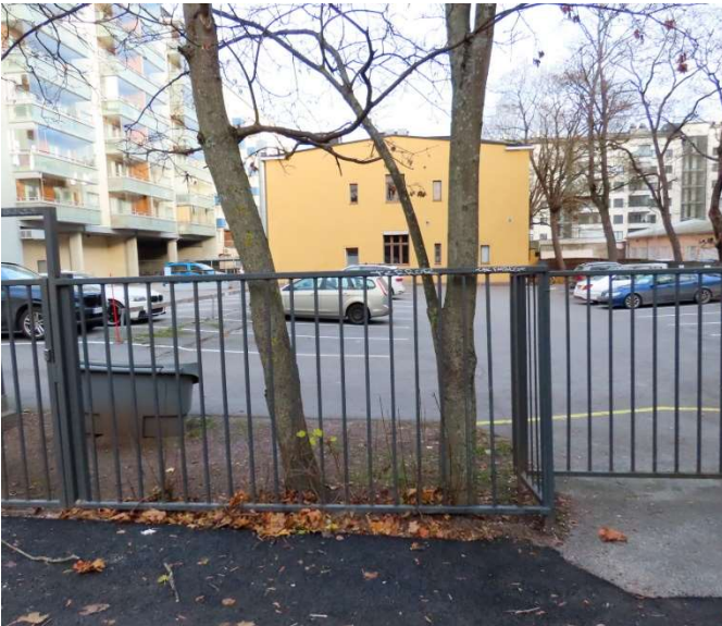
Kuva 9. Vaahteroiden 6 ja 7 rungot kasvavat kiinni aitaan.
