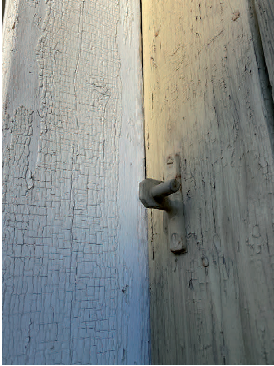
Julkisivuissa ovat osin jäljellä alkuperäisten markiisien hakaset.
