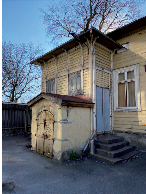
Vuoden 1885 uudistuksessa lisätty porrashuone ja kellarihalssi 1700-rakennettuun kellariin.
