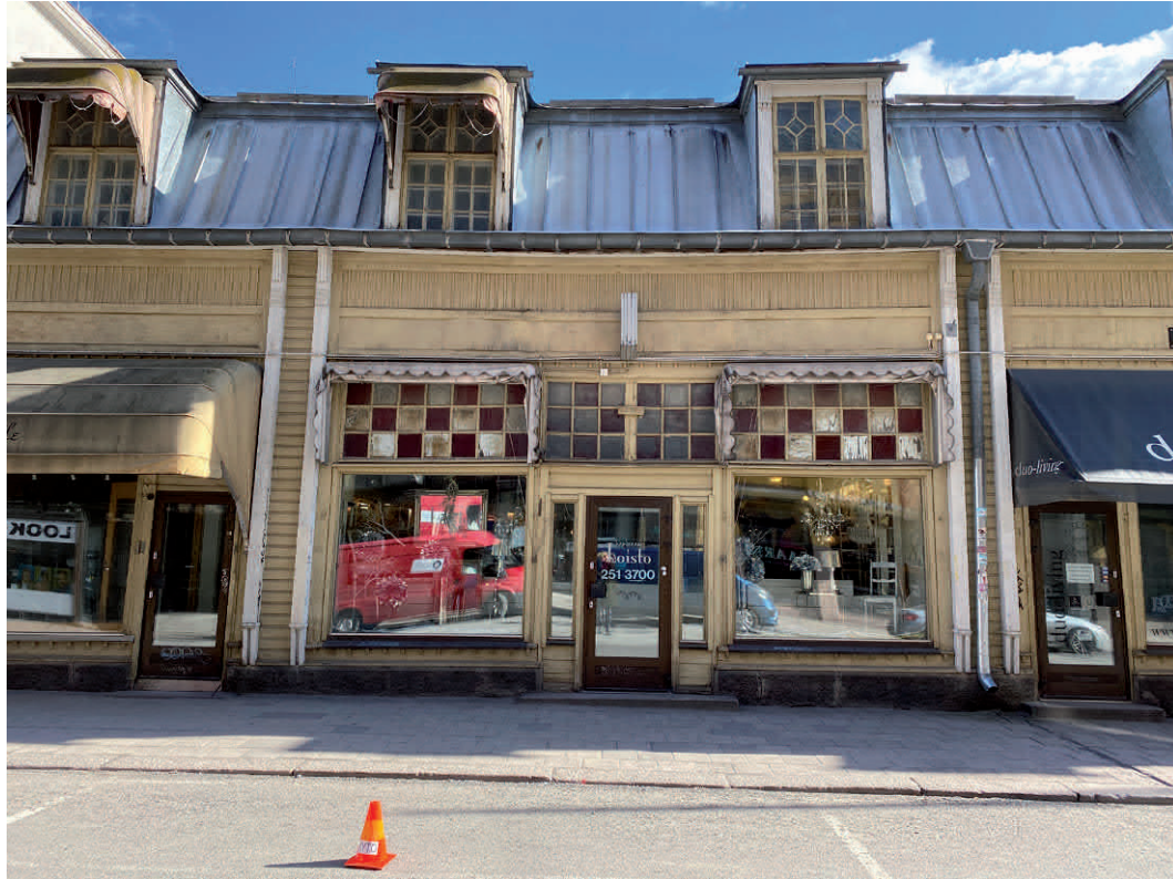
Rakennuksen kauppiaaskadun puolen julkisivut ovat osin detaliikkaa myöten 1910-luvulta.
