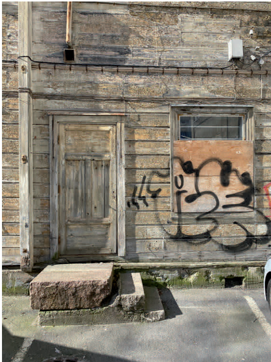
1920-luvulla tehty sisäänkäynti ja 1830-luvun leveää julkisivulaudoitusta.
