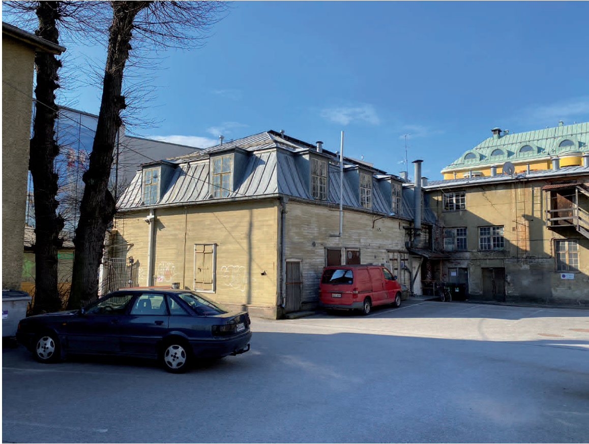
Linnankadun puoleinen pihajulkisivu on laudoituksineen 1830- ja 1840-luvuilta lukuun ottamatta 1920-luvulla toteutettua kattoa.
