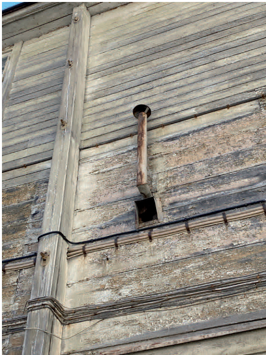
Alempana 1830-luvun laudoitusta ja ylempänä 1920-luvun korotusosan laudoitusta. Ilmanvaihtuventtiili ja -putki ovat 1920-luvulta.
