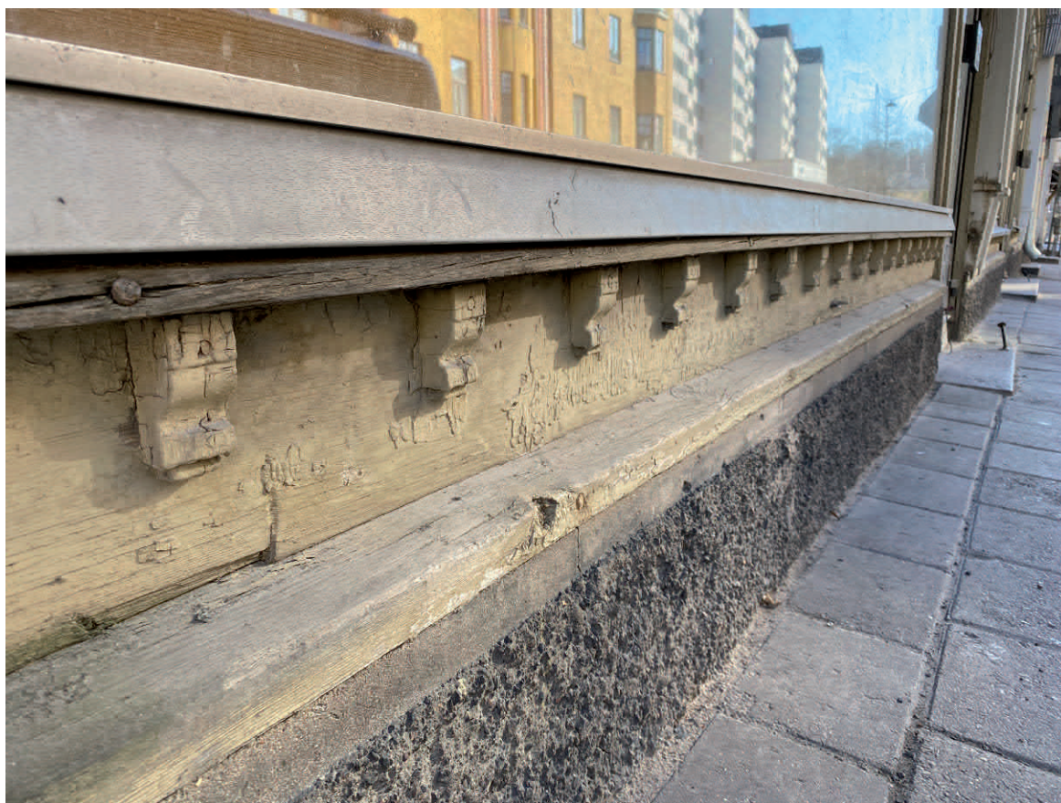
1910–1920-lukujen julkisivudetaaliikkaan kuuluvat puiset konsolit ovat tallella kauttaaltaan.
