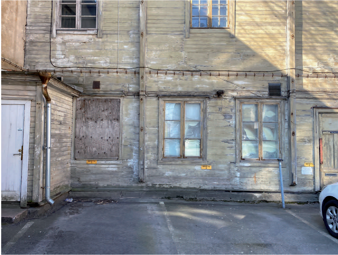
Pihajulkisivun kolme kuusiruutuista ikkunaa ovat 1830-luvun lopulta. Julkisivussa on näkyvissä myös niitä edeltänyt 1820-luvun kuistin lappeen jälki ajalta, jolloin keskimmäisen ikkunan paikalla sijaitsi ovi 1828–1837.
