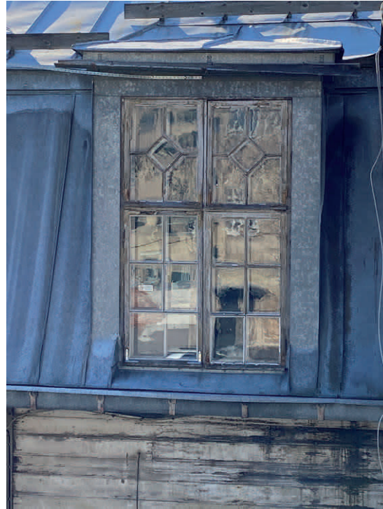
Toisen kerroksen 1920-luvun ikkunat ovat jugendtyylisiä, ja valtaosaltaan ne ovat säilyneet alkuperäisinä.
