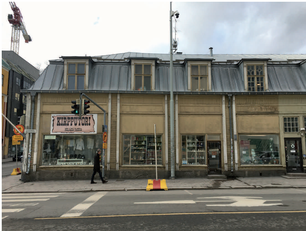
Kirpputorin kohdalla näyteikkunoiden pieniruutuiset yläikkunat on peitetty levytyksellä.
