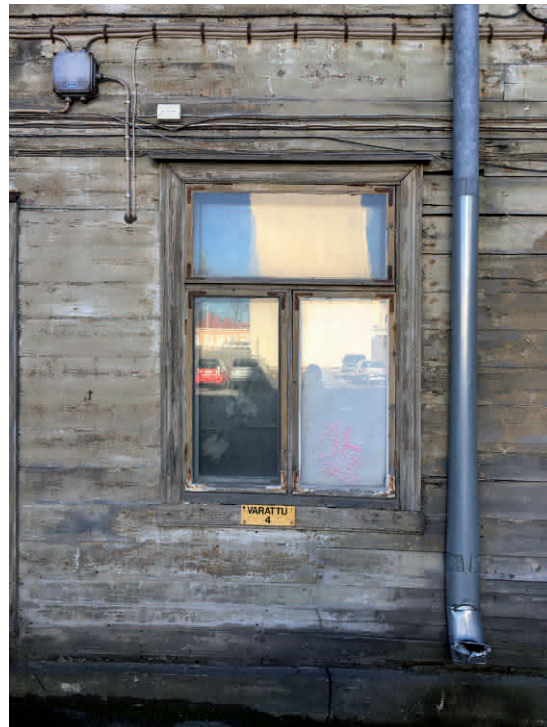
1920-luvun T-ikkuna Kauppiaskadun puolen pihajulkisivussa.
