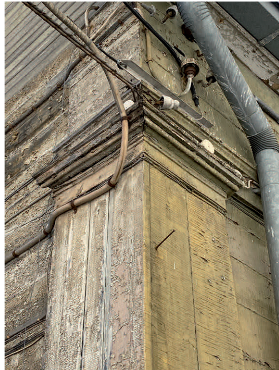
1830-luvun lopussa toteutettu klassistisen pilasterin puinen kapiteeli on säilynyt rakennuksen pohjoisnurkassa. Sähkövedot ovat 1900-luvun jälkipuoliskolta.
