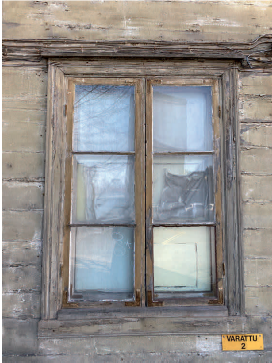
Vanhimmat ikkunat ovat peräisin 1830-luvulta, ja niitä on rakennuksen pihajulkisivussa kolme kappaletta.
