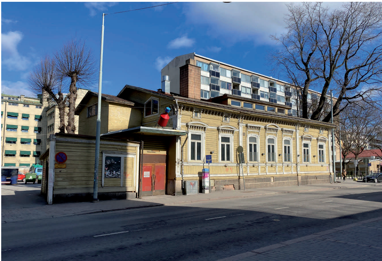
Katujulkisivu Linnankadulle. Etualalla 1950-luvun porrashuone ja vanhimmilta osiltaan 1800-luvun aita.
