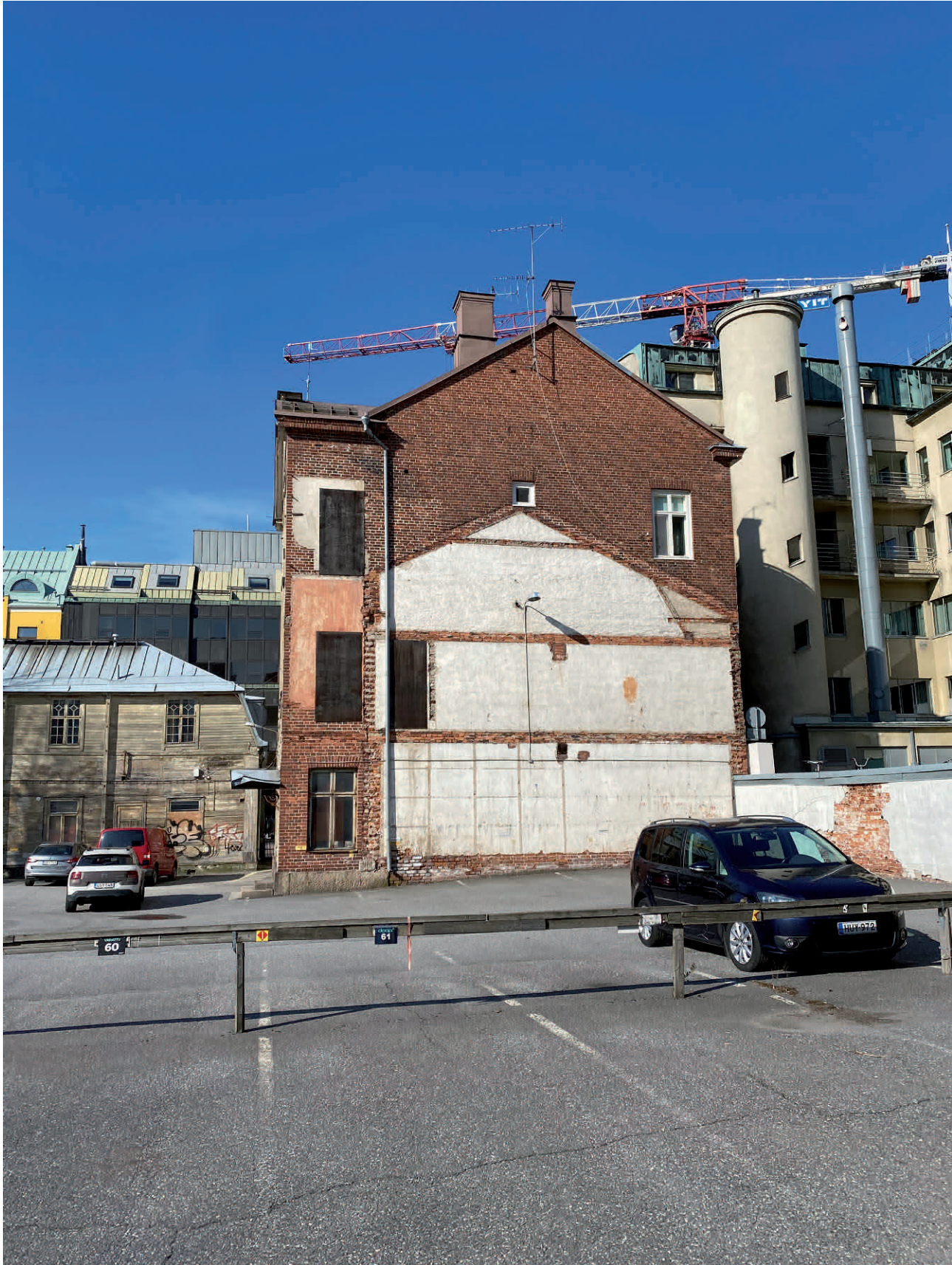
Viereinen sivu ja yllä: Kivitalon pihajulkisivuissa on porrashuoneessa ja ullakolla alkuperäiset ikkunat. Brahenkadun puoleisessa julkisivussa on näkyvillä 1990-luvun lopulla puretun talousrakennuksen kerrosjako ja kattorakenne.
