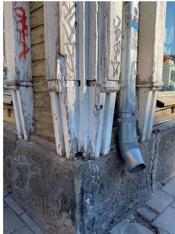
Pilasterien/följarien jalustat on muotoiltu kapeneviksi ja sovitettu kvaaderikivijalkaan.
