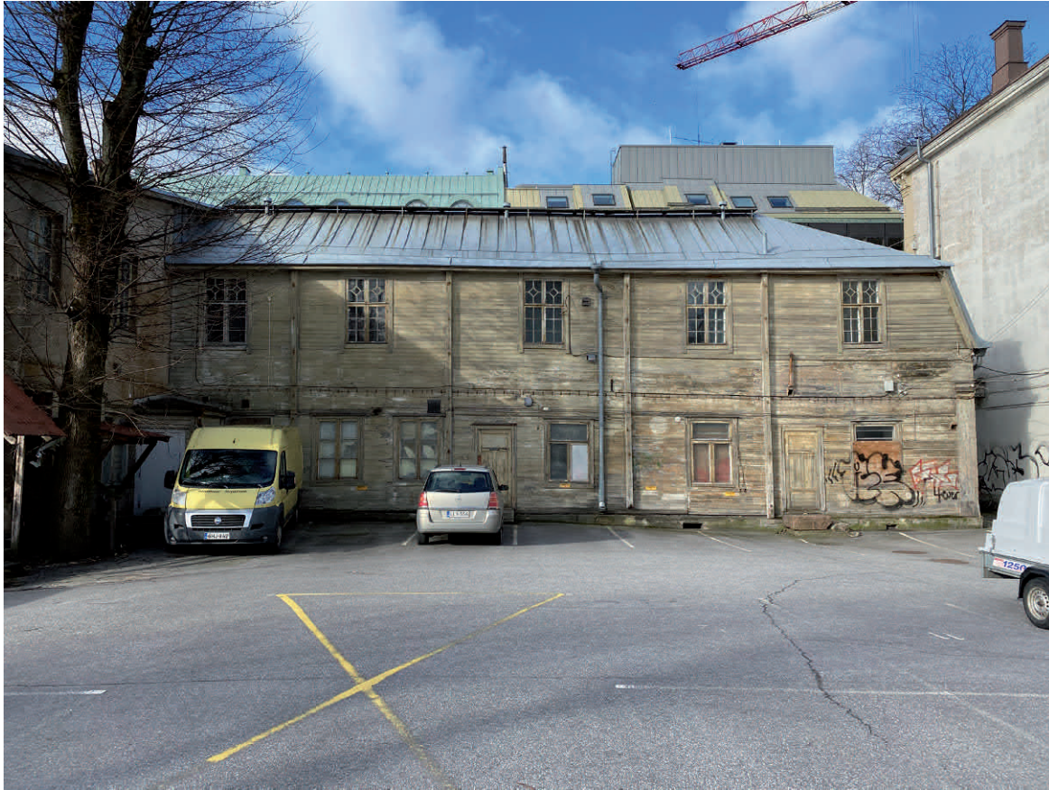
Kauppiaskadun puolen pihajulkisivussa ovat näkyvissä rakennusvaiheet 1820-luvun lopulta 1920-luvulle. Ensimmäisen kerroksen tasolla on sekä 1820-luvun lopun että 1830-luvun lopun julkisivulaudoitusta.
