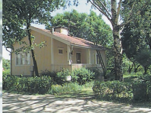
Vientihöyläämö Oy:n tyyppitalo alkuperäisessä asussaan, Kupittaankatu 64.
