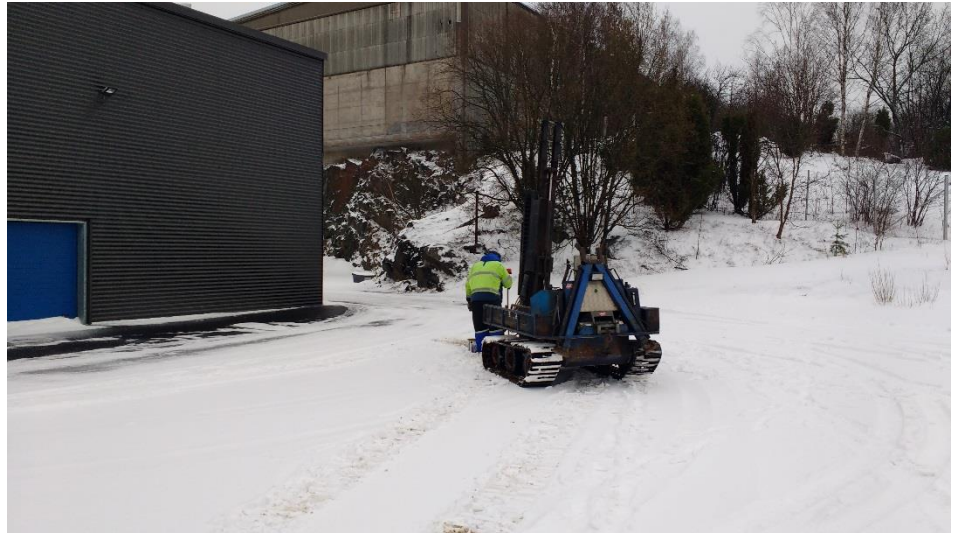
Kuva 5: Kairauspisteen täyttö käynnissä kiinteistöllä 853-74-74-29.
