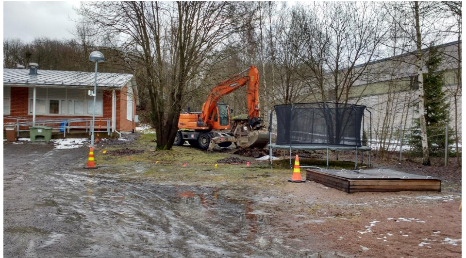
Kuva 3: Senaatin alue, koekuopan kaivu käynnissä.
