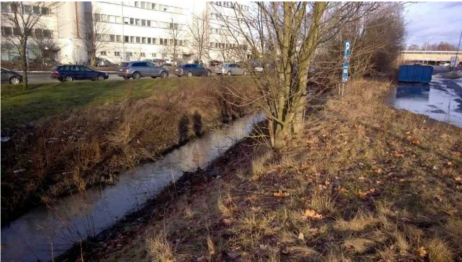
Kuva 3. Pitkämäenkadun alittavat rummut 2 x 1400B (ylemmät kuvat) sekä näkymä Pitkämäenkadun vierestä koilliseen Klinkkerikadulle (alin kuva).
