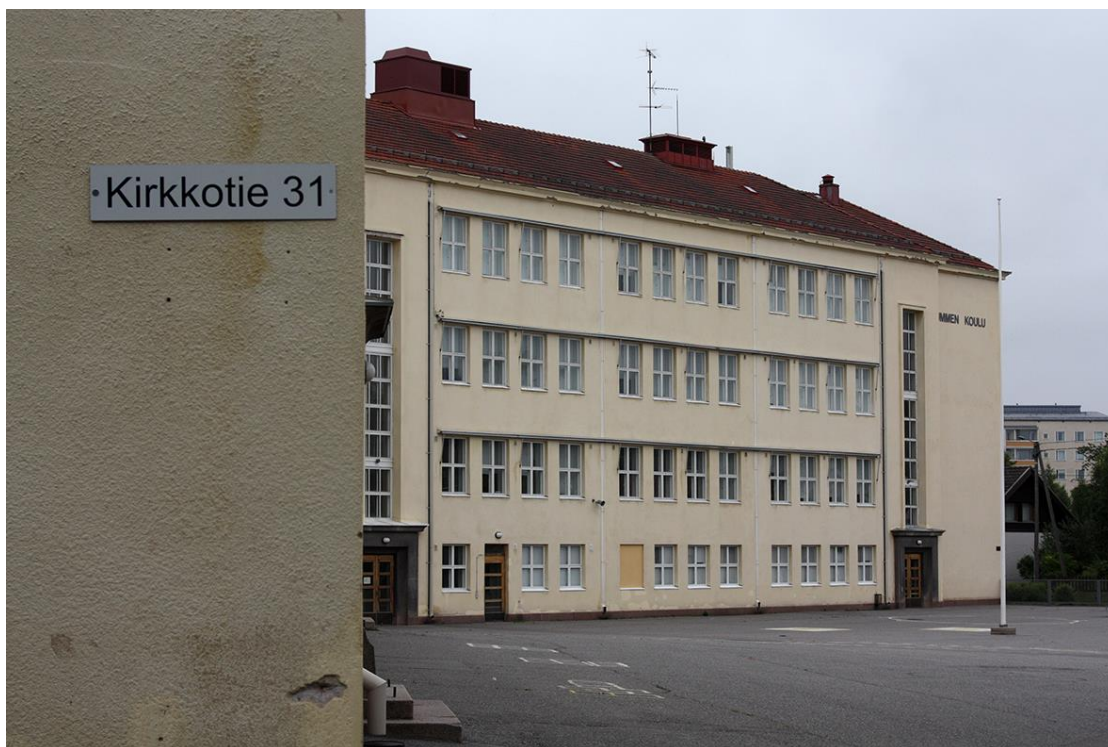
Kuva 4. 1930-luvulla rakennetussa koulurakennuksessa toimii Nummenpakan koulun Nummen yksikkö ja Katariinan koulu. Rakennus on uudempaa liikuntasalisiipeä lukuun ottamatta asemakaavalla suojeltu.
