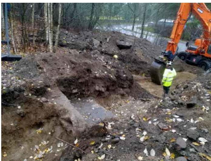
Kuva 16. Koekuoppia tontin pohjoisrinteeltä. (valokuva: Muuritutkimus Oy)
