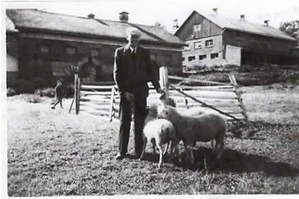
Kuva 3. Kuikkulankatu 8:n tutkimusalueella 2 sijainnut, 1990-luvun lopussa purettu navettarakennus (oik. yläkulma) ja nykyisellä Kuikkulankatu 6:n tontilla edelleen sijaitseva navettarakennus kuvattuna pohjoisesta vuonna 1946. Nykyinen Kuikkulankadun linjaus kulkee kuvan etualan pellolla. Matti Bergströmin vuoden 1973-74 kaivausalueet ovat sijainneet kuvan oikeassa reunassa näkyvällä alueella. Kuva: Antti Kurpan yksityisarkisto, liitetty raporttiin A. Kurpan luvalla.
