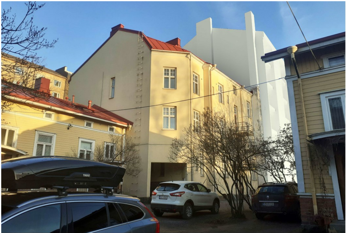
Kuva 28. Näkymä Puistokatu 18:n kivitalon savupiippujen korottamisesta (Schauman Arkkitehdit Oy, 1.4.2020). Osoitteessa Puistokatu 18 sijaitseva asunto-osakeyhtiö on ilmoittanut elokuussa 2020, että oikeanpuoleista piippua ei tarvitse korottaa kuvassa esitetyllä tavalla. Vasemmanpuoleisen piipun korottaminen on kuitenkin tarpeen, jos uusi kerrostalo rakennetaan kuvan mukaisesti.
