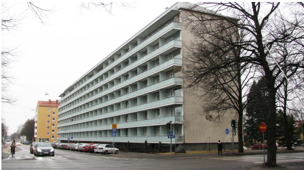
Kuva 5. Rauhankatu 19–21:n kerrostalo (kuvannut Satu Tiainen 3.3.2017).
