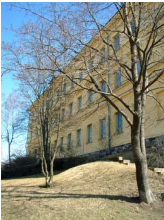
Korttelin vanhin rakennus, entinen vaivaistalo, rakennettiin Kurjenkaivonkentalle v. 1834.
