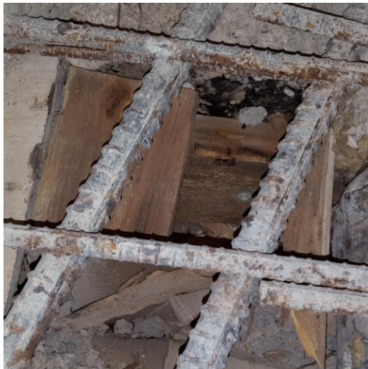
Kuva 10. Putkikanaalin kohdalla on puuainesta.
