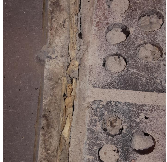
Kuva 2. Tila 024, Rivinteerauksen ja pintabetoni- laatan välissä on pahvia.
