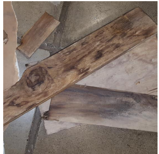
Kuva 11. Putkikanaalin kohdalla on puuainesta.
