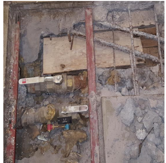
Kuva 9. Putkikanaalin kohdalla on puuainesta.
