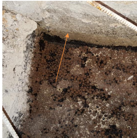
Kuva 6. Tila 024, Ulkoseinässä ei paikoin ole bitumisivelyä, kuvan seinärakenne on silminnähden märkä alaosastaan.
