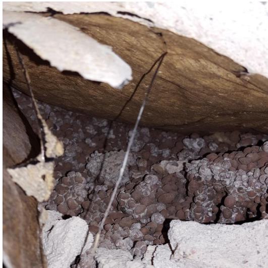
Kuva 5. Tila 024, pintabetonilaatan alla on valukreppi.
