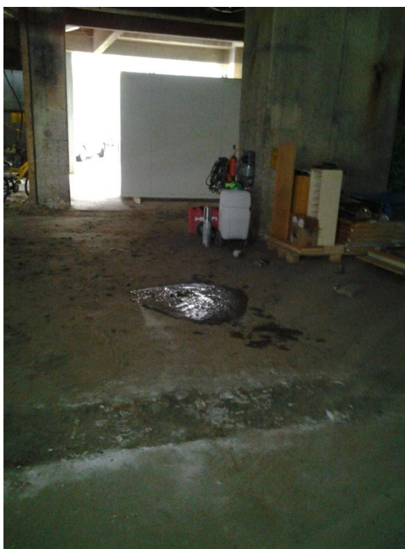
Kuva 2: Tutkimuspisteen S5 alue. Tutkimuspisteen takana timanttipora, jolla läpäistiin betonilaatta.
