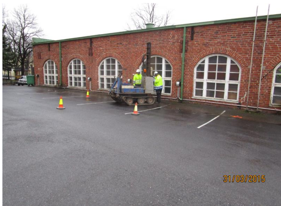
Kuva 4. Tutkimuspiste S10 sijoitettiin piha-alueella sijainneen 25 MW kaasuturbiinin alueelle.
