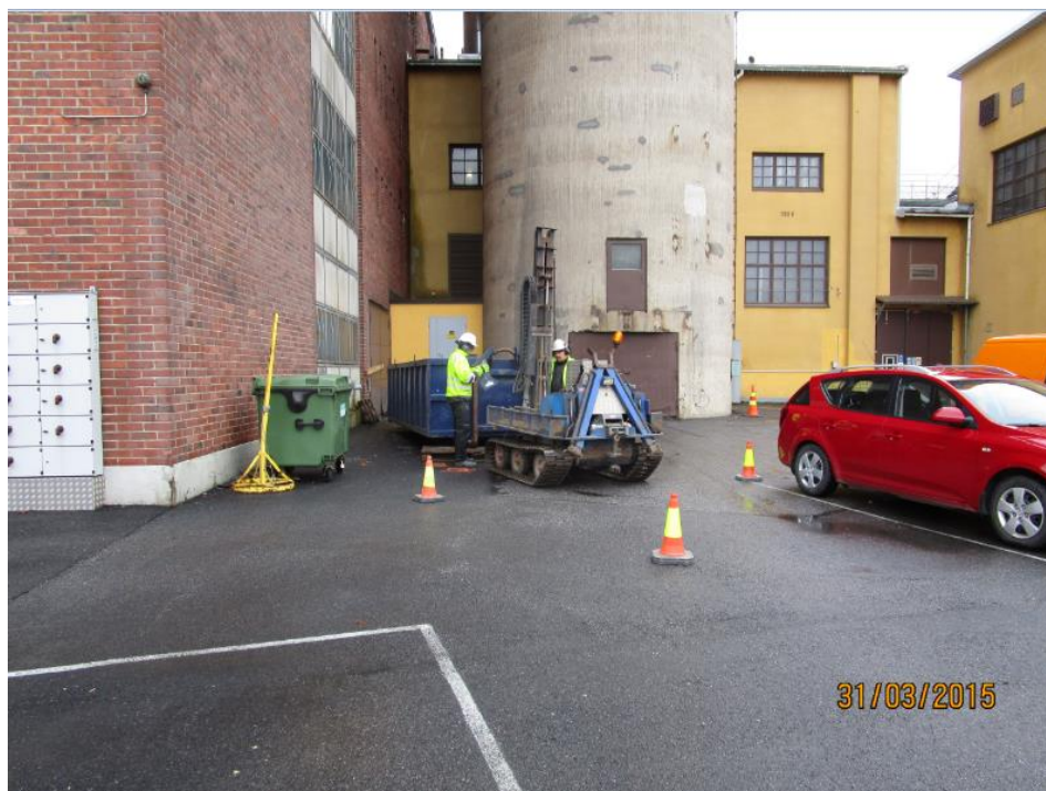
Kuva 3. Näytepisteen S8 alueella todettiin VNa 214/2007 ylemmän ohjeavron ylittäviä PAH-pitoisuuksia. Kuvassa vasemmalla voimalaitoksen vanha kattilarakennus.
