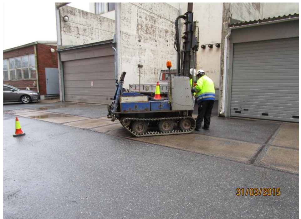
Kuva 6. Käytöstä poistetun sähköasemarakennuksen muuntamorakenteiden alueelle tehtiin näytepisteet S20 (kuvassa) ja S21.
