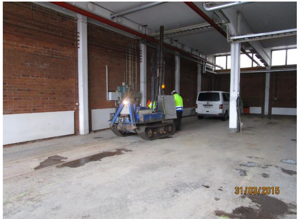
Kuva 1. Näytepisteen S2 kairaus autotallirakennuksen sisällä.
