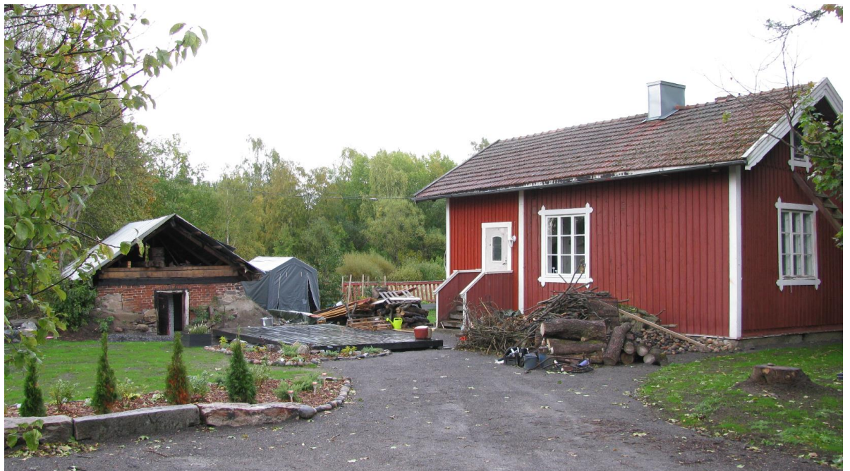
Kuva 8. Ratavahdille kuulunut asuinrakennus 1870-luvun lopulta osoitteessa Jokipellonkuja 30. Vasemmalla on rakennuksen pihapiiriin kuuluva kellari.
