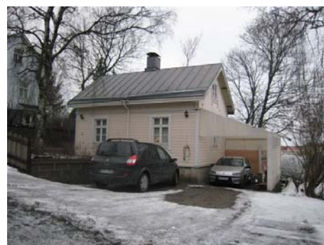
Talousrakennus ja autokatos
