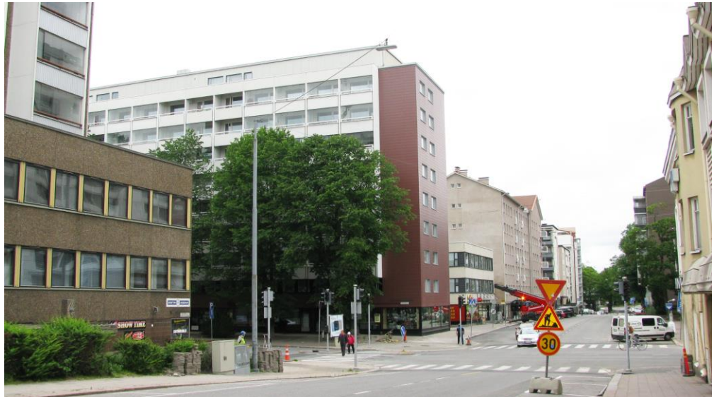
Valokuva suunnittelualueen rakennuksista. Kuva on otettu kaakosta päin Käsityöläiskadulta. (Kuvannut Satu Tiainen 4.7.2017).
