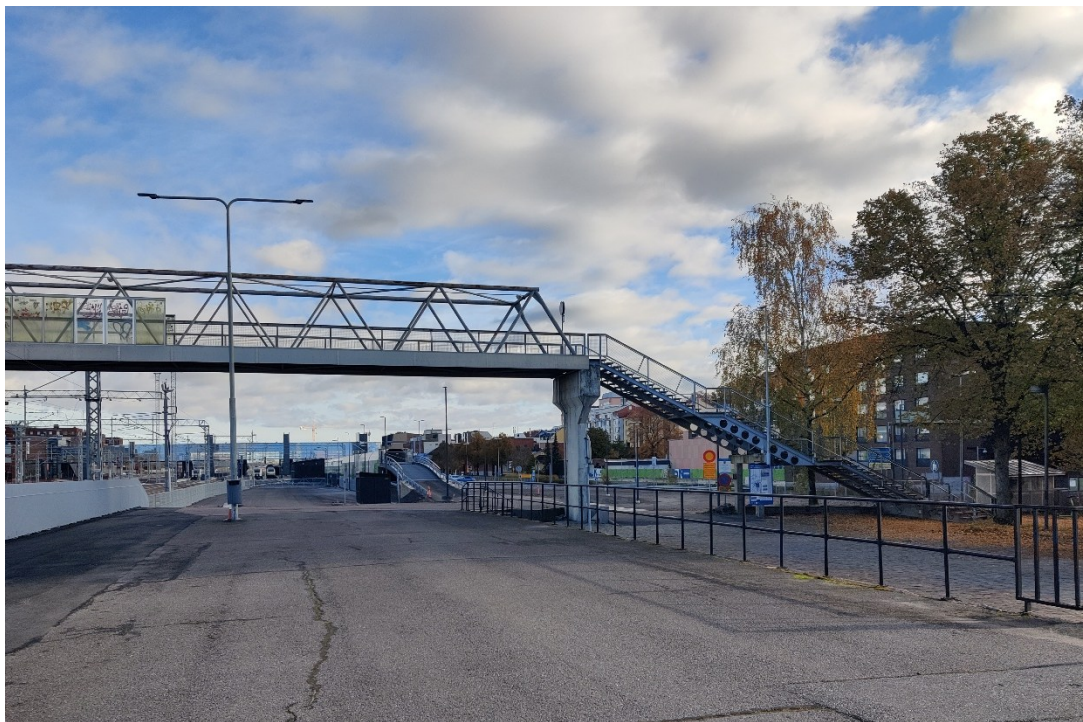
Kuva 13. Humalistsilta ja autonlastauslaituri asemarakennuksen suunnasta kuvattuna. (Valokuva syksy 2025, Laura Virkki)
