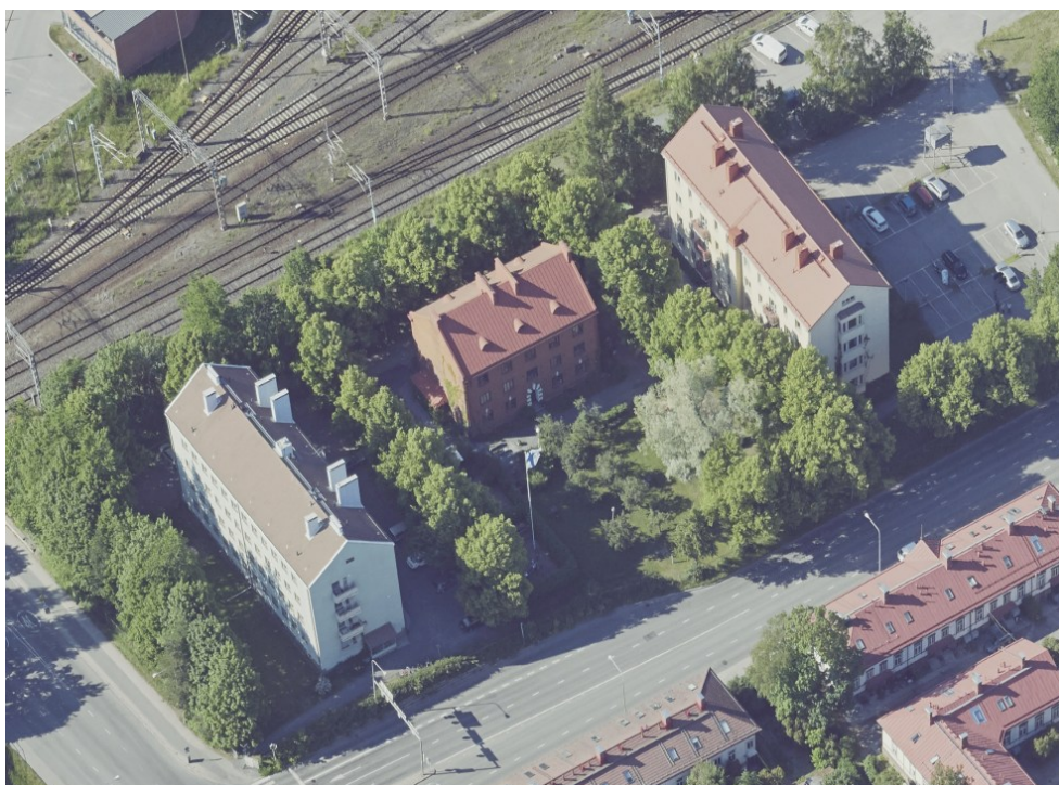
Kuva 18. Viistoilmakuvassa (2022) osoitteissa Ratapihankatu 43, 35 ja 47 sijaitsevat rakennukset. ©Turun kaupunki
