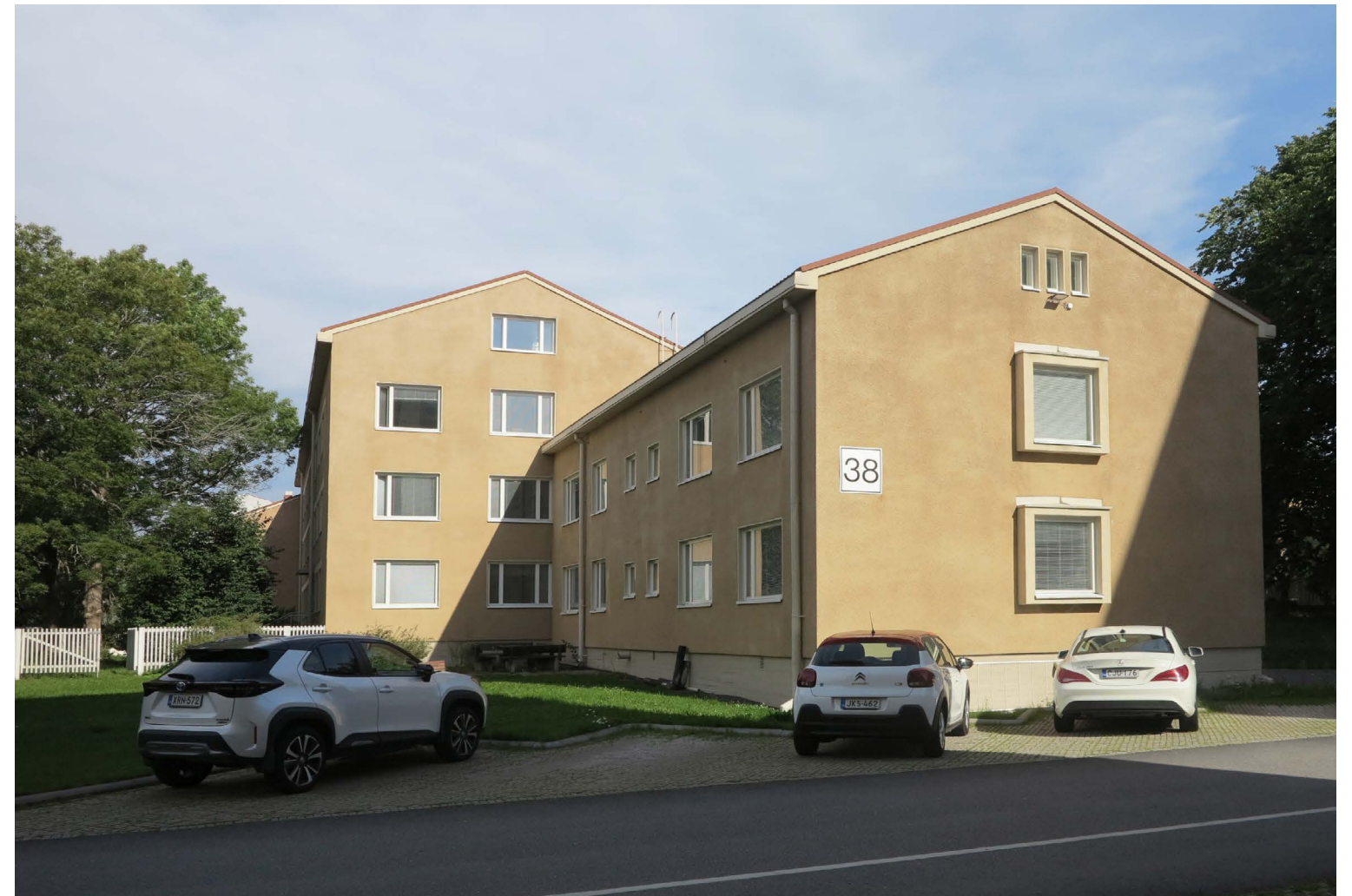
Myös kaakkoispäädyn 1-ruutuisiin ikkunoihin liittyy erityisenä aiheena ulkoneva kehyslista.
