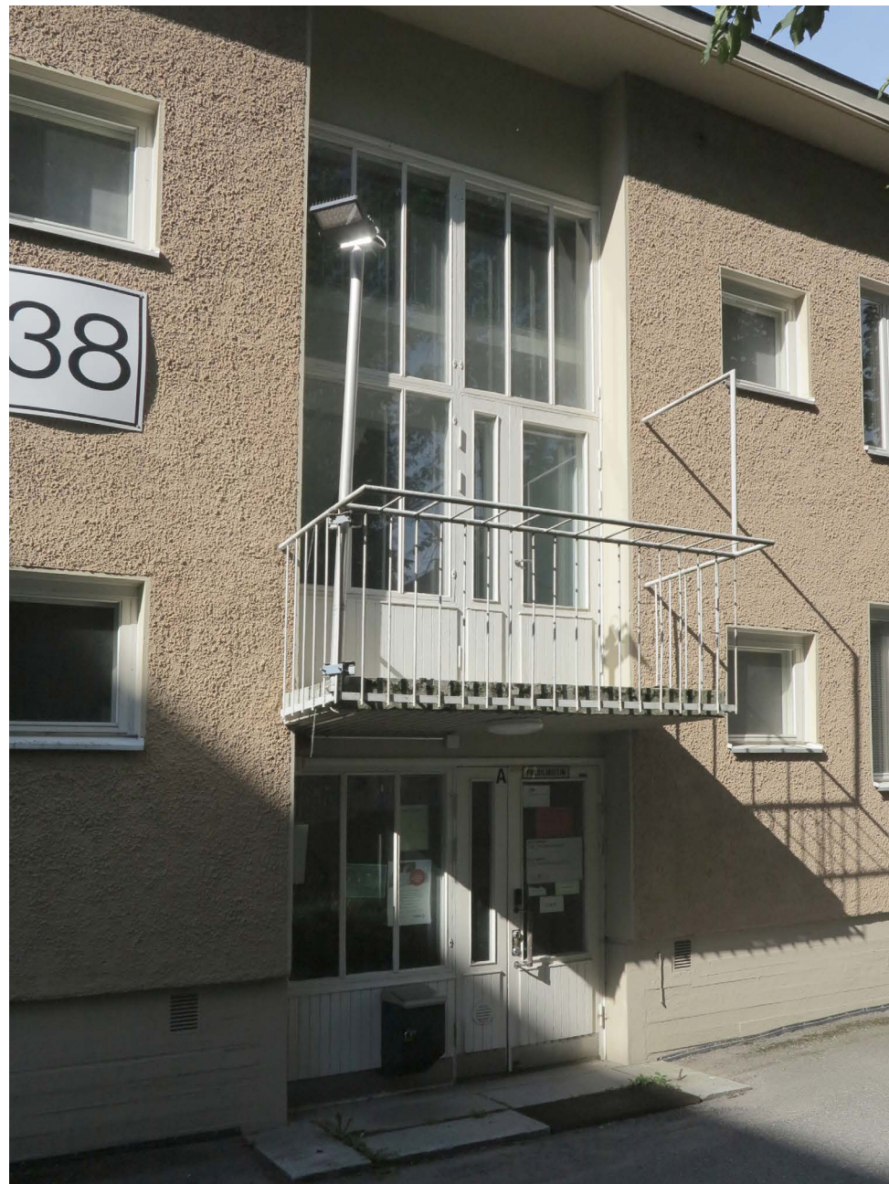
Eteläisen lamellin porrashuoneessa on säilynyt alkuperäiset ulko-ovet ja parveke-ovet sekä näihin liittyvät laajat ikkunapinnat. Tuuletusparveke pinnakaiteineen on myös alkuperäinen.
