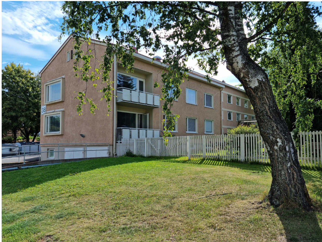
Asuntola Kurjenmäentien liittymästä nähtynä. Päätyjulkisivussa korostuu aiheena ikkunoiden ulkoneva kehyslista. Parvekekaiteiden betonilevyt saattavat olla myöhemmin lisättyjä.
