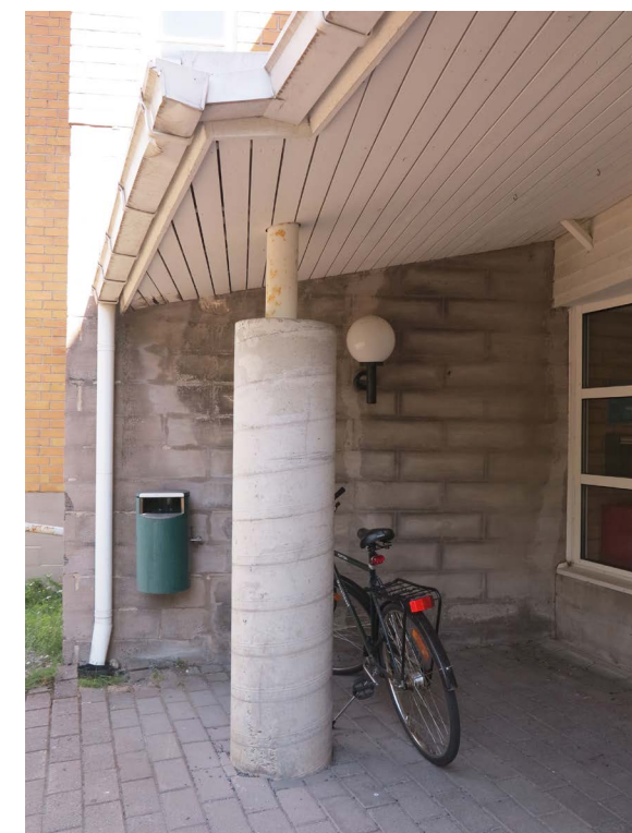
Kurjenmäkikoti 2 sisäänkäynnin yhteydessä olevassa slammatussa betoniseinässä on valumajälkiä mitkä yhdessä erilaisten harmaiden betonipintojen kanssa tekevät yleisilmeen jokseenkin epäsiistiksi. Muotoiltu katos betonipilareineen on alkuperäinen.
