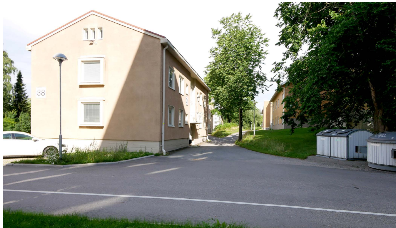
Luoteispäädyn ilmettä on muuttanut myöhemmin lisätty porrashuone pystyjakoisine ikkunoineen. Porrashuone on rakennettu alkuperäisen avoportaiden ympärille. Sisäänkäyntien edustalle pihatien reunaan sijoitetut syväkeräysastiat korostuvat kaupunkikuvassa.
