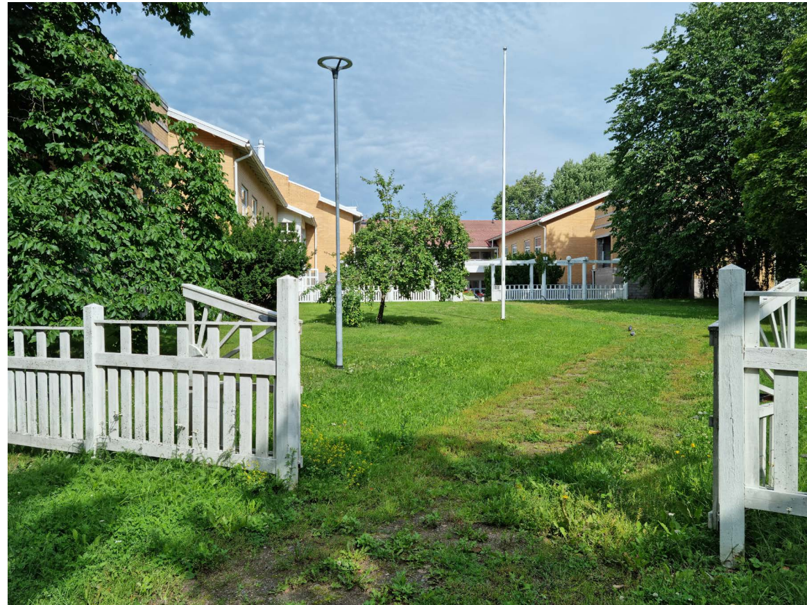
Kurjenmäkikotien yhteispihaa on rajattu puu-aidalla. Portin kautta avautuu näkymä kohti Kurjenmäkikoti 2 rakennusta.
