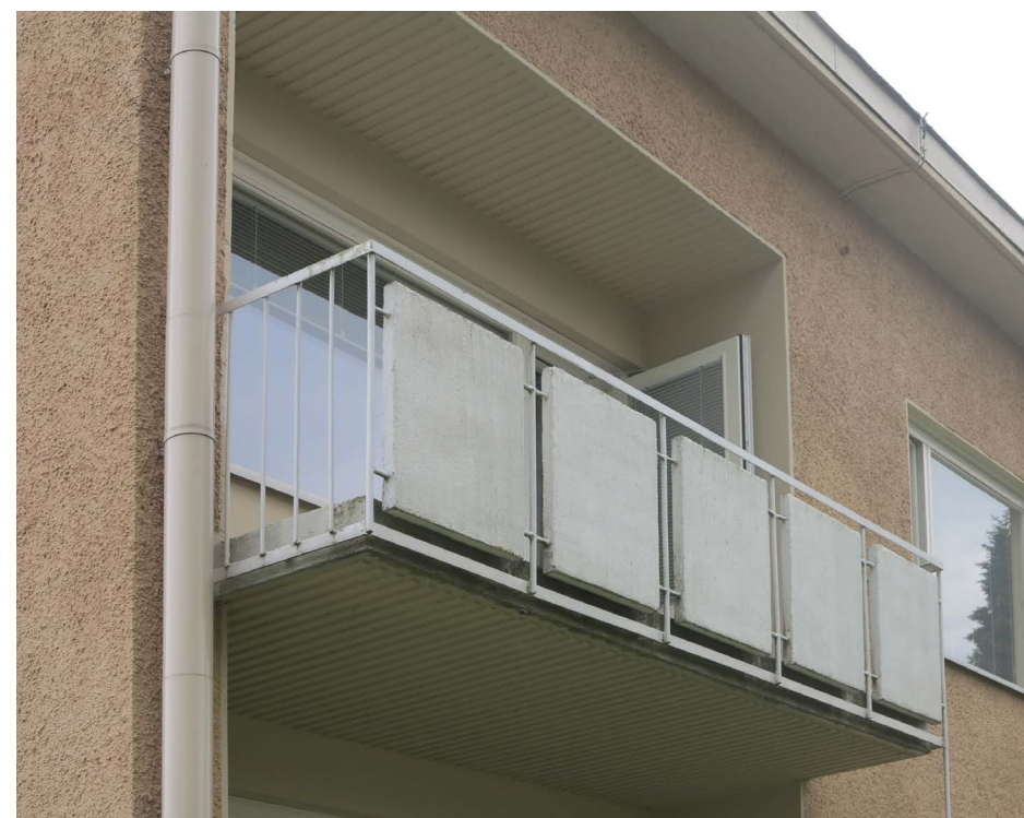
Parvekekaiteessa on käytetty teräspintojen ohella näkösuojaa antavia betonilevyjä.
