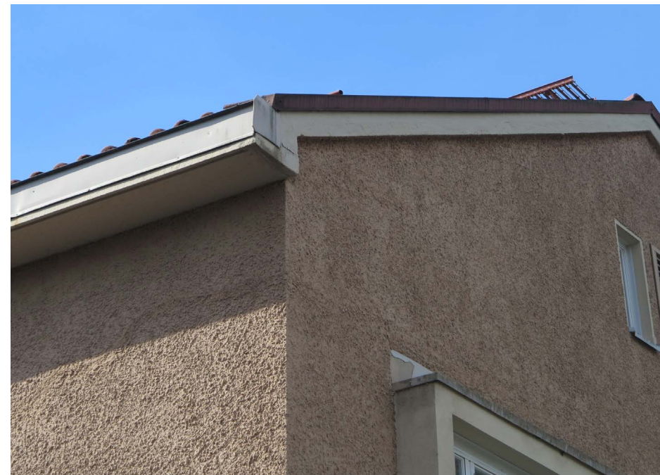
Betonirakenteiseen räystääseen liittyy sisäänrakennettu vesikouru.
