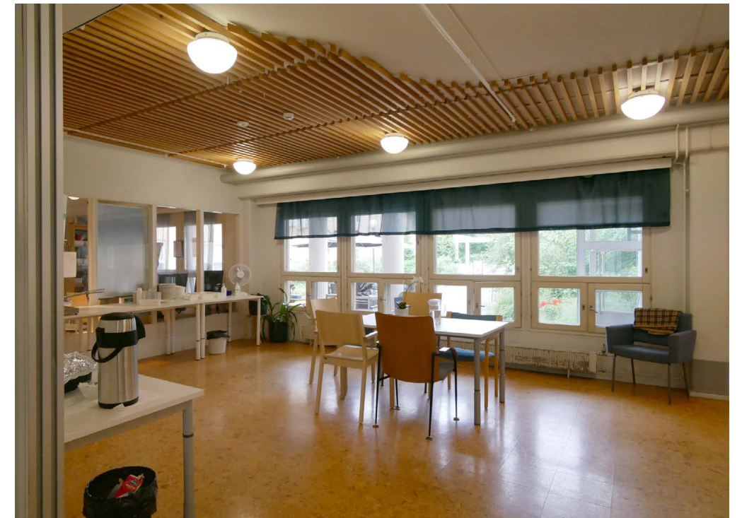
Kurjenmäkikoti 1, 1.krs keittiö ja ruokailutilassa on korkkimatto, kattopintaa elävöittää puurituläverhaus.
