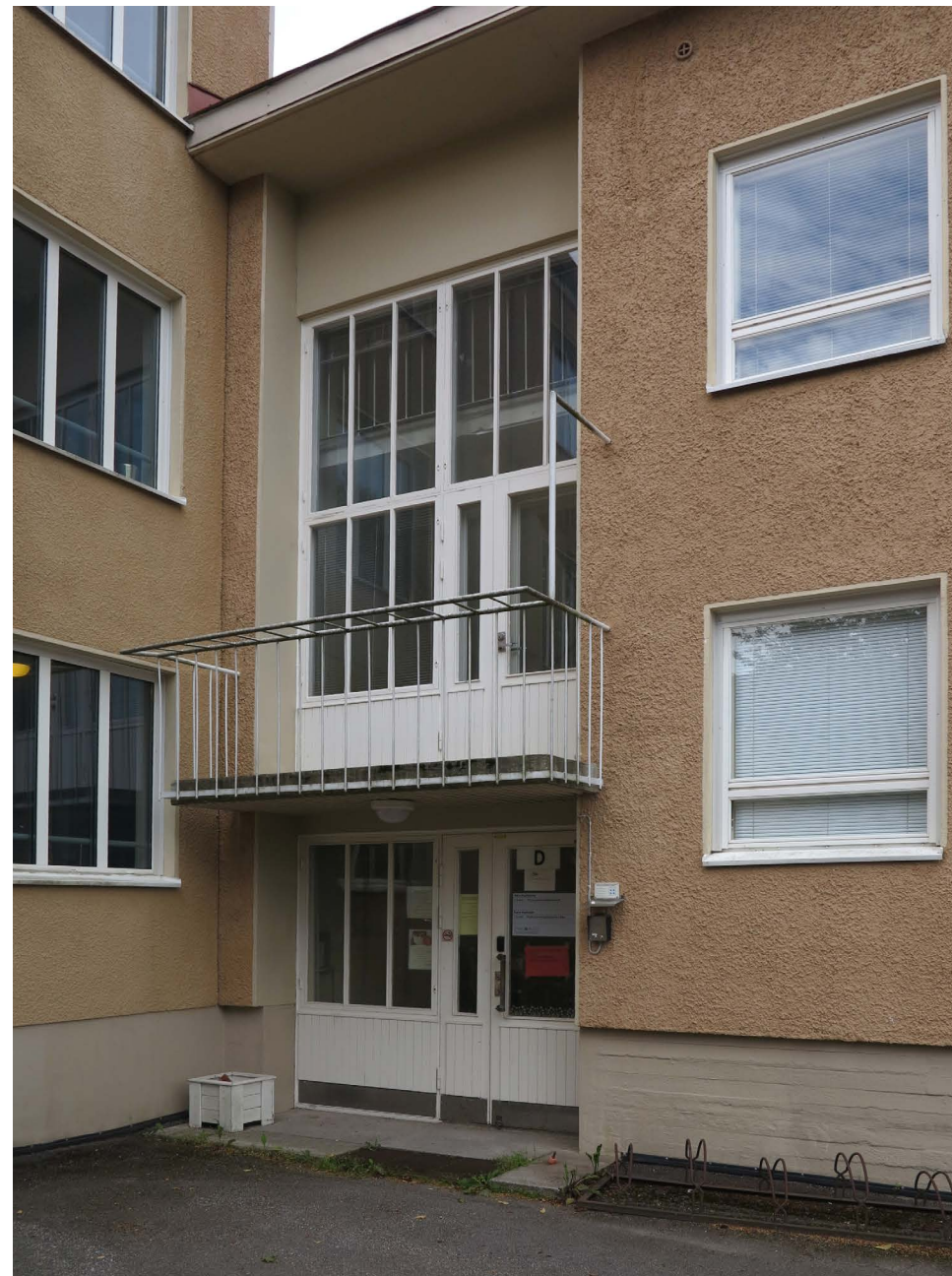
Pohjoiseen päätylamellin liittyy vastaava porrashuone ikkunaseinineen ja tuuletusparvekkeineen. Vasemmalla näkyy vuonna 2008 rakennetun hissien ja porrashuoneen laajennus. Rappauspinnan struktuuri poikkeaa laajennusosalla alkuperäisestä roiskerappauksesta.
