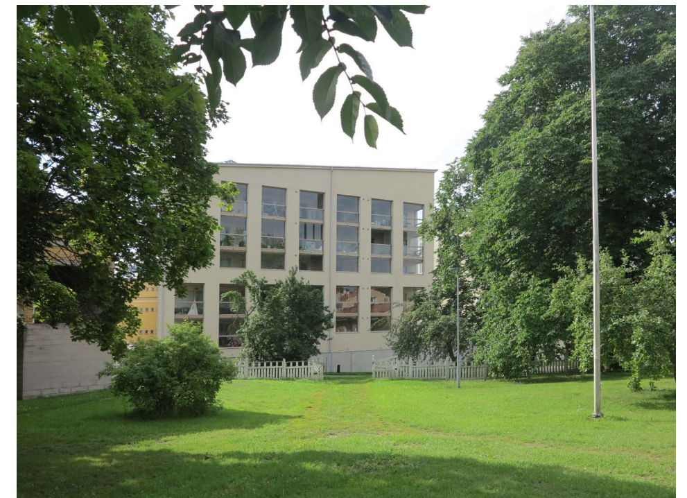
Vuonna 2021 valmistunut uudisrakennus rajaa Kurjenmäkikotien pihan etelässä.
