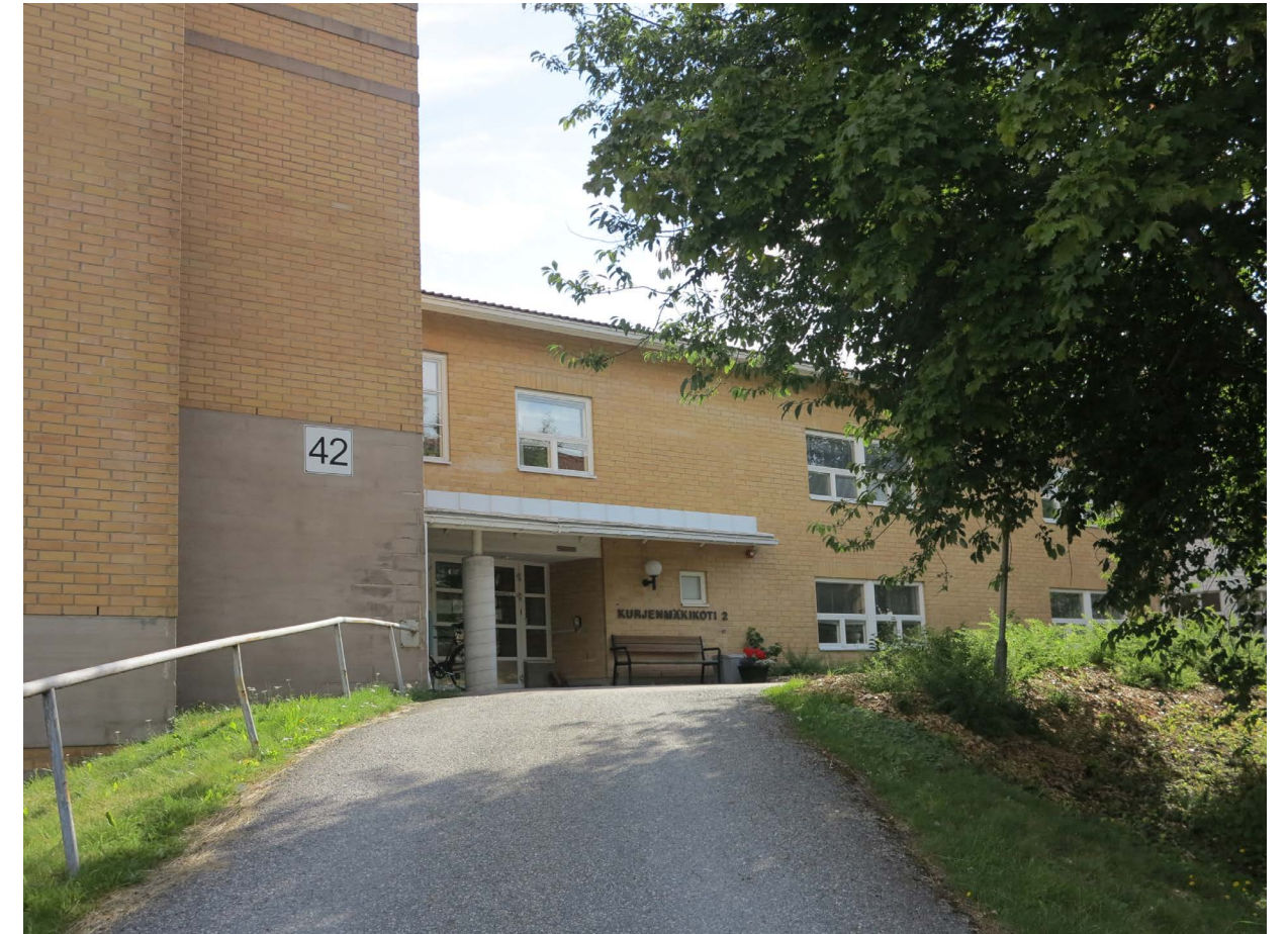
Kurjenmäkikoti 2 sisäänkäynnin yhteydessä olevassa slammatussa betoniseinässä on valumajälkiä mitkä yhdessä erilaisten harmaiden betonipintojen kanssa tekevät yleisilmeen jokseenkin epäsiistiksi. Muotoiltu katos betonipilareineen on alkuperäinen.
