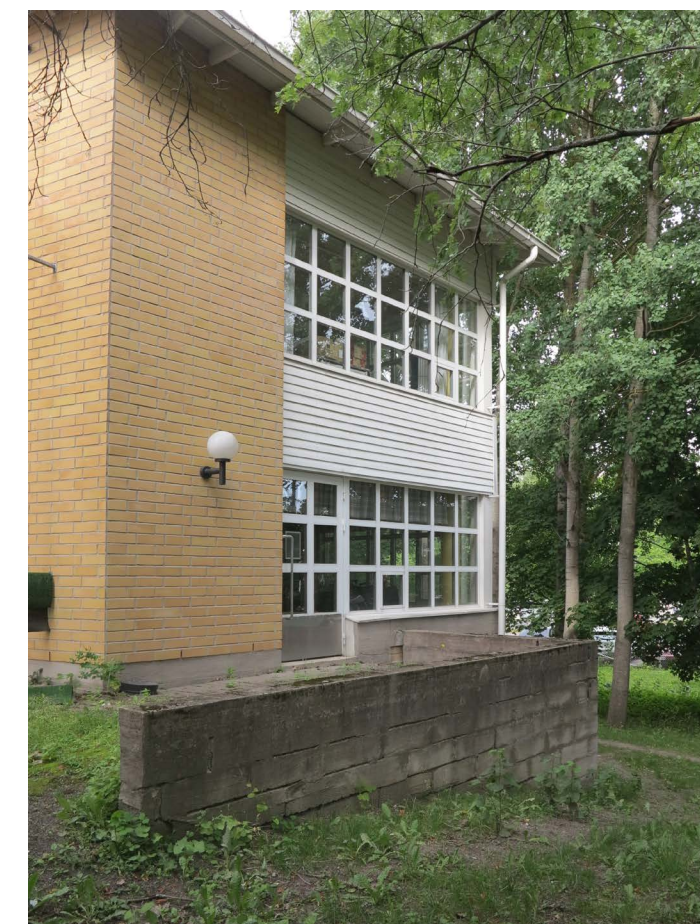
Oikealla ylhäällä ja alhaalla kuvat Kurjenmäkikoti 2 koillisnurkalta. 1. kerroksen oleskelutilaan liittyy terassi joka ei ole käytössä. Sokkelia on korostettu raita-aihein.
