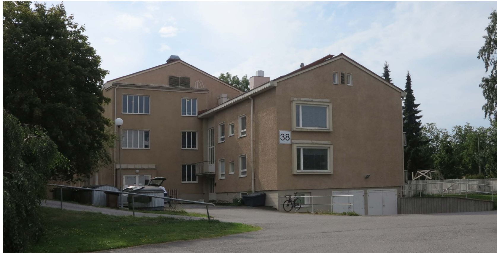
Luoteispäädyn ilmettä on muuttanut myöhemmin lisätty porrashuone pystyjakoisine ikkunoineen. Porrashuone on rakennettu alkuperäisen avoportaiden ympärille. Sisäänkäyntien edustalle pihatien reunaan sijoitetut syväkeräysastiat korostuvat kaupunkikuvassa.
