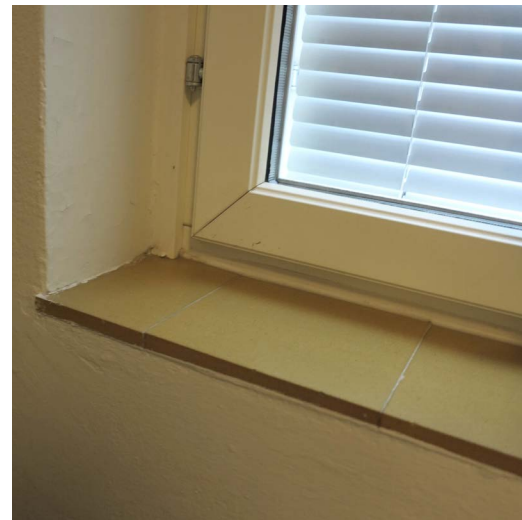
Keraamisella laattalla päällystetyn ikkunanpenkin yksityiskohta.
