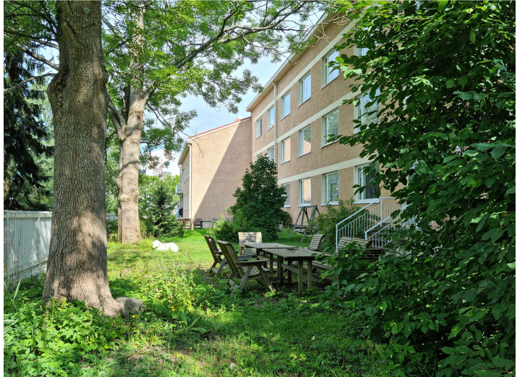
Keskiosassa on ulkoseinän betonipalkki jätetty sileäpintaisena maalattuna raita-aiheena näkyviin. Alkuperäisissä suunnitelmiin ikkunoiden alapuolelle merkittyä levyrakennetta ei ole toteutettu tai se on myöhemmin muutettu.
