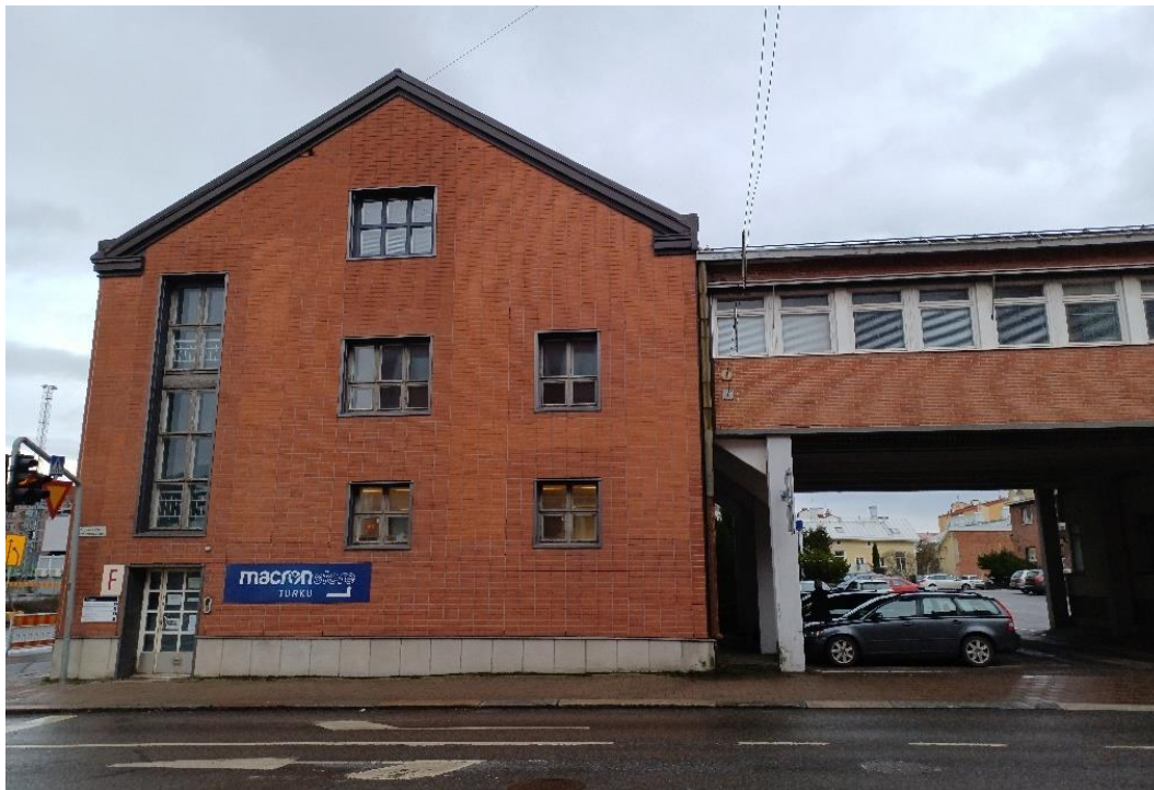
Kuva 78 Rakennuksen Ajurinkadun puoleinen pääty ja sisäänkäynti. Ikkunat ovat suureksi osaksi alkuperäiset, puupuitteiset kitti-ikkunat. Siltamainen uudisosa on liitetty rakennuksen kylkeen 1950-luvun lopulla.
