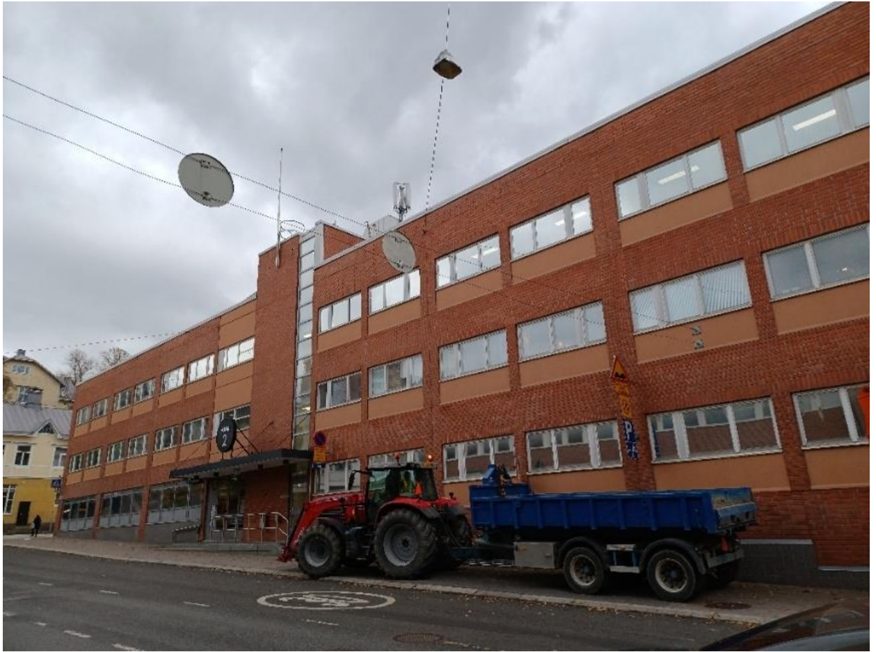
Kuva 124 (ylhäällä) Julkisivu Ajurinkadun puolelta.
