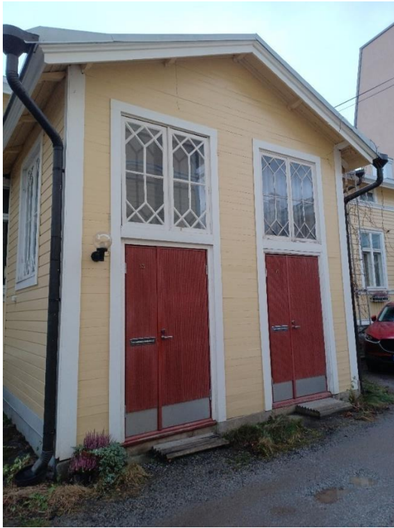
Kuva 46 (vasemmalla) Kuistien ikkunat vaikuttavat alkuperäisiltä, mutta ovet ovat 1950-luvun tyyliset sormipaneliovet.
