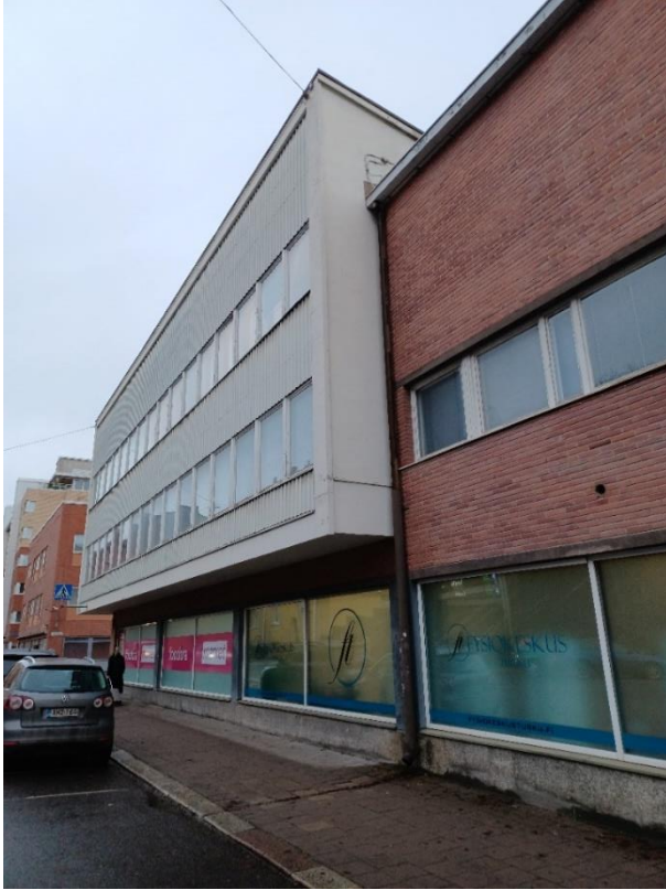
Kuva 108 (vasemmalla) Rakennusosien liitoskohta Läntisellä Pitkädulla.
