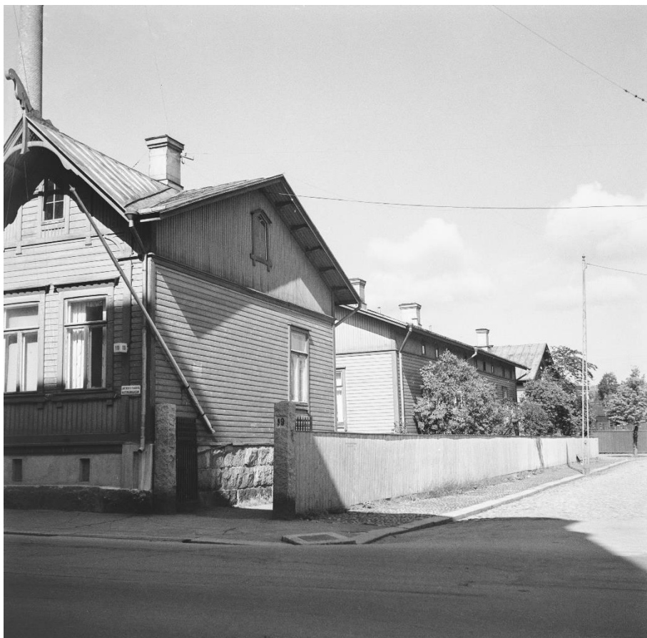
Kuva 56 Läntinen Pitkäkatu 19 (rakennus 4) Kauppiaskadun puolelta, 1956. Kauppiaskadun pohjoispää on sittemmin suljettu, ainoastaan kapea kuja on jäänyt portin kohdalle. (Kuva: M. Sjöblom / Turun museokeskus.)
