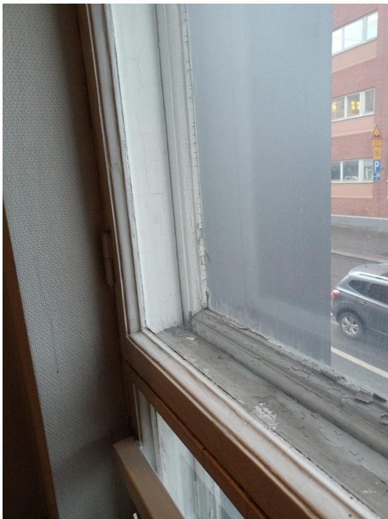
Kuva 81 Myös ikkunat ovat profiilinsa perusteella peräisin 1930-luvulta.
