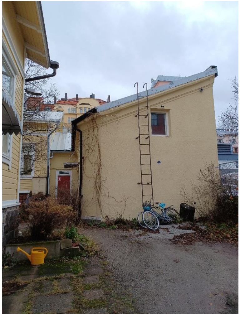
Kuva 67 (oikealla) Rakennus 5:n pääty. Kuvan suunta kohti kaakkoa.
