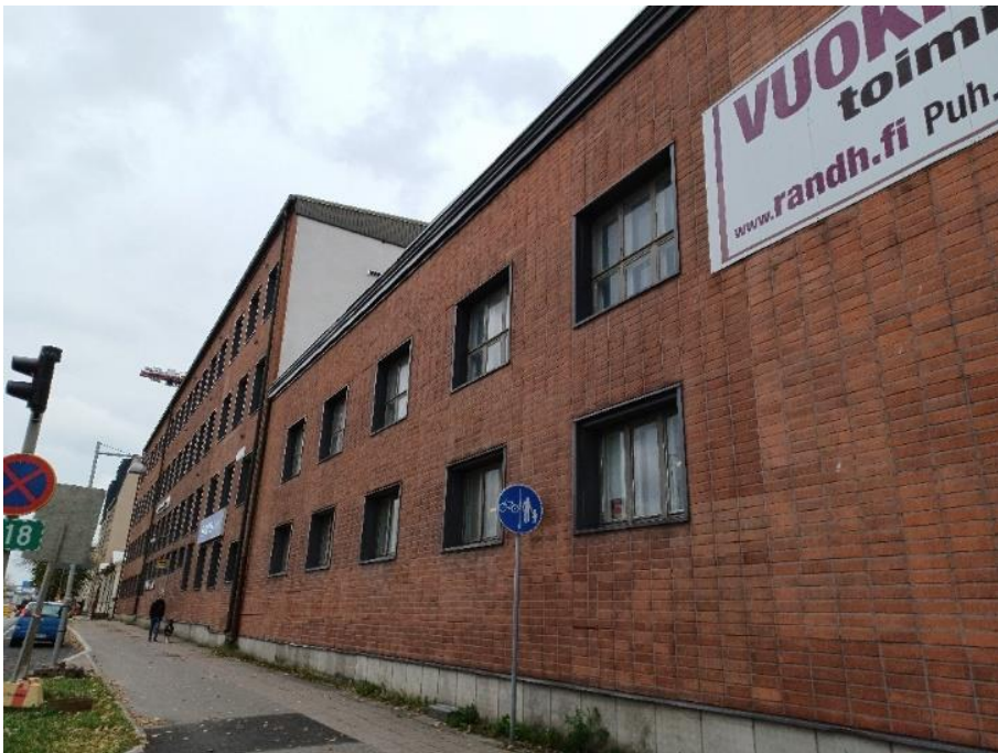
Kuva 73 Rakennuksen ny- kyistä julkisivua Ratapihanka- dun puolella. Osa puupuittei- sista kitti-ikkunoista on säily- nyt, mutta ikkuna-aukot ovat paksun lisäeristyksen ja tiili- vuorauksen vuoksi jääneet sy- välle seinän sisään.
