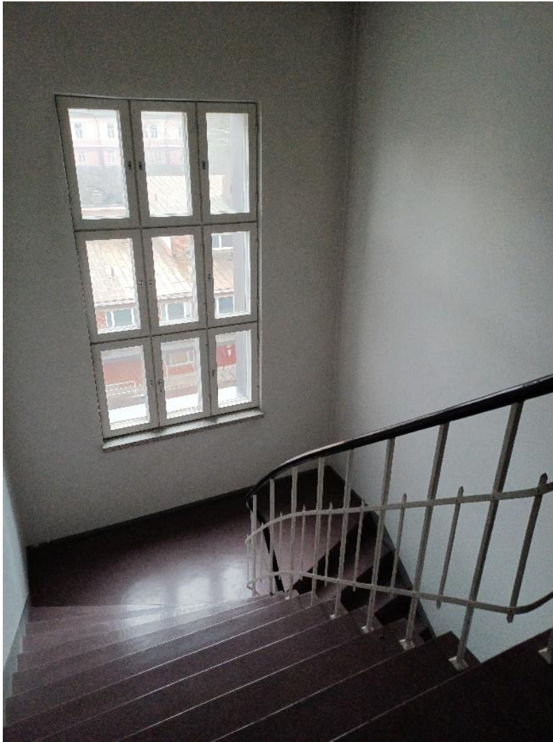
Kuva 97 Rakennuksen keskivaiheilla sijaitseva porrashuone on vielä alkuperäisen kaltaisessa asussa.
