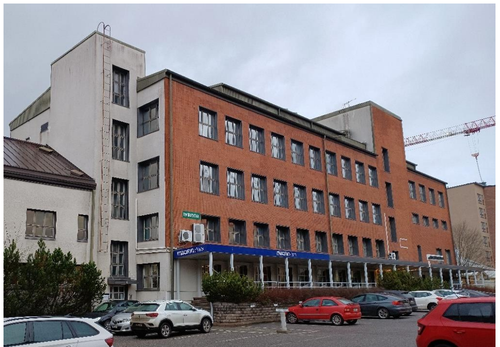
Kuva 90 Sama julkisivu vuonna 2021. Rakennuksen ulkomuoto on voimakkaasti muuttunut uuden ulkovuorin ja detaljimuutosten myötä. Laivamainen funkisulkoasu on muuttunut tehdasmaiseksi. Päädyssä sijainnut varistorakennus on purettu.
