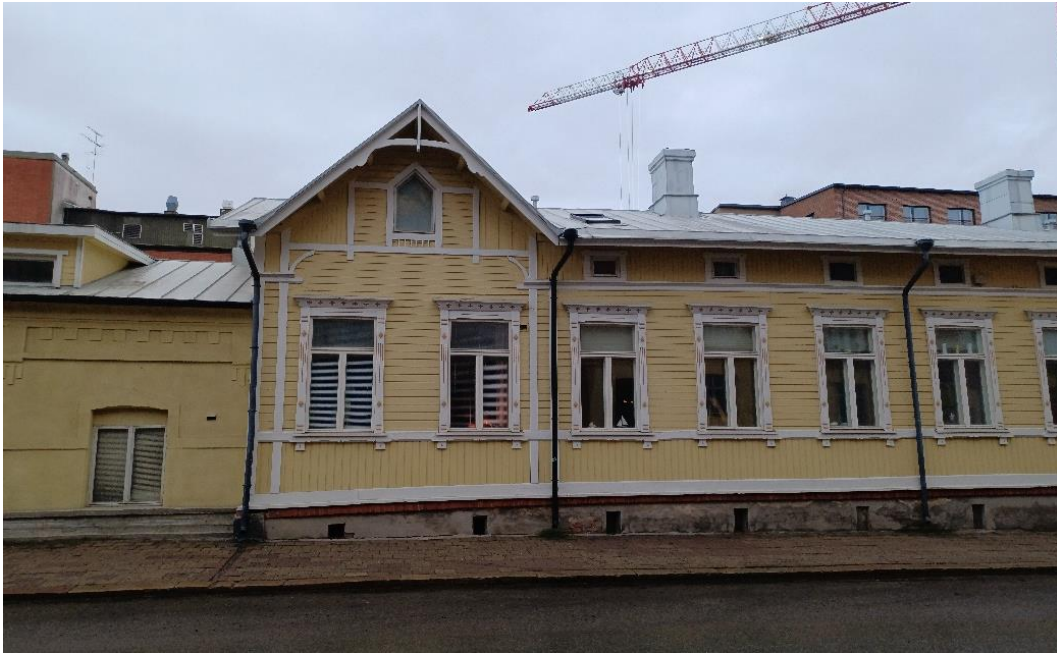
Kuva 58 Rakennus 4:n toinen pääty Lätisen Pitkäkadun puolelta. Alkuperäispiirustuksissa ja vuoden 1956 valokuvissa ei näy tämän päädyn korotettua, päätykolmiollista osaa, eli se on lisätty vuoden 1956 jälkeisissä julkisivumuutoksissa.
