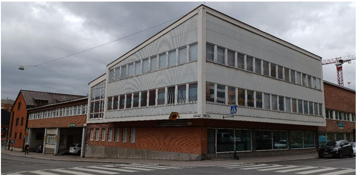
Kuva 99 Kuva samalta paikalta 60 vuotta myöhemmin. Rakennuksen aaltometallipinta on ollut alun perin nykyistä tummempi. Katutason ikkunoita on suurennettu liiketiloja varten.
