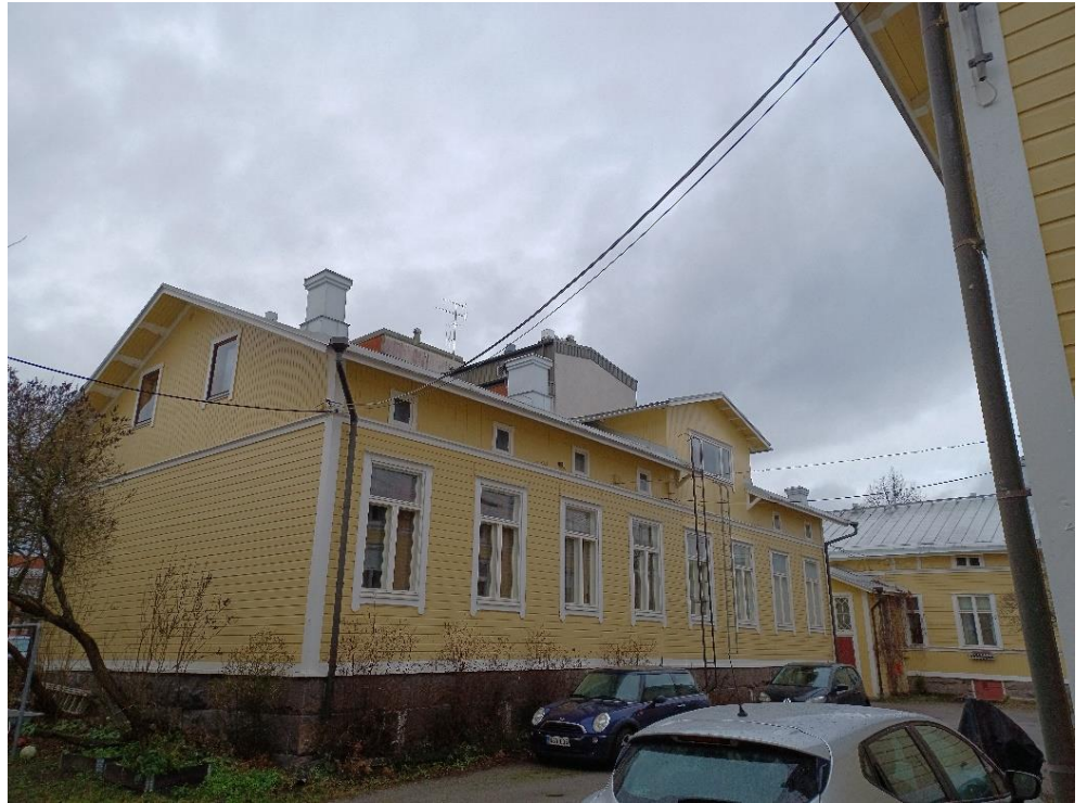
Kuva 53 Rakennus 3 ja taustalla rakennus 1.
