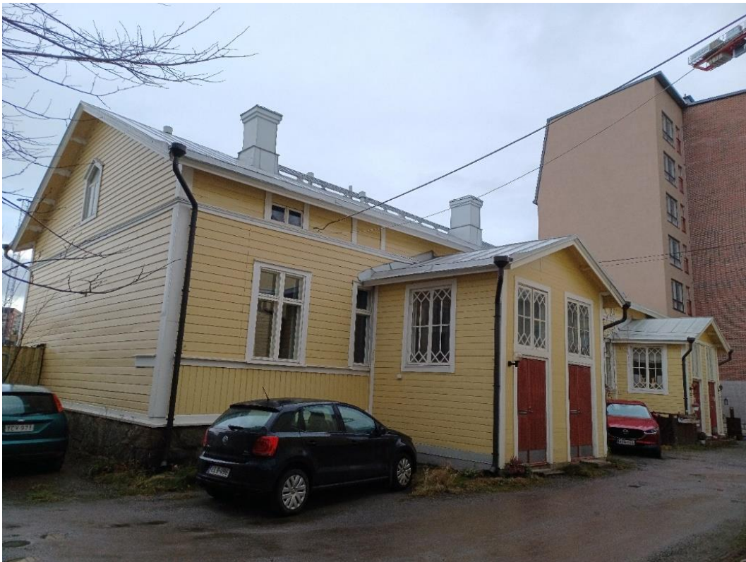
Kuva 43 Rakennus sisäpihan puolelta.
