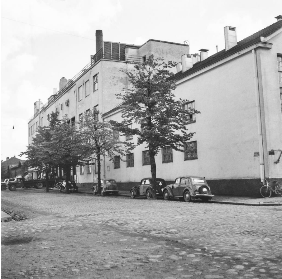
Kuva 72 Valion meijeri (vas.) ja varas- torakennus (oik.) Ratapihanka- dulta, 1956. Meijerin sisään- käynti on sijainnut rakennuk- sen keskellä Ratapihankadun puolella. (Kuva: M. Sjöblom / Turun museokeskus.)
