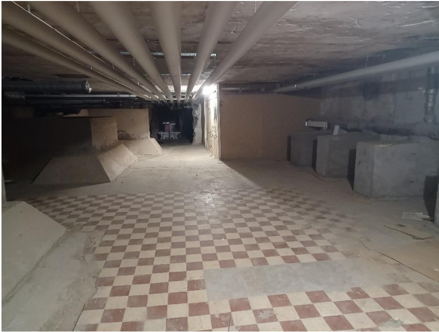
Kuva 95 Alkuperäistä meijerin lattiaa kellaritilassa. Kuvassa näkyy massiivisia tukirakenteita, joita on valettu kauttaaltaan koko kahden rakennuksen kellaritilojen mitalta estämään rakennuksen painumista.
