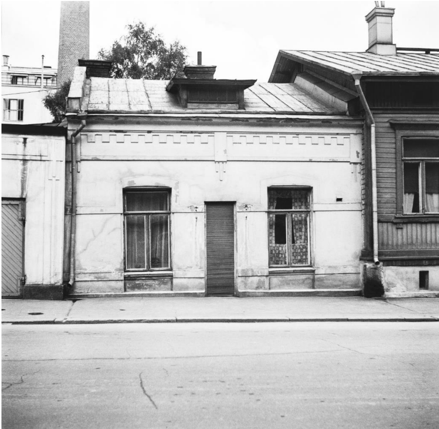
Kuva 62 Rakennus 5 on näyttänyt tältä vuonna 1956. Tämän jälkeen on oviaukko muurattu umpeen, samoin ikkunoiden ylimmät aukot. Kattolyhtyä on myös hieman muutettu. Ilmeisesti myös kadun pintaa on korotettu (vrt. ikkuna-aukkojen sijainti ja viereisen rakennuksen kissanluukut). (Kuva: M. Sjöblom / Turun museokeskus.)
