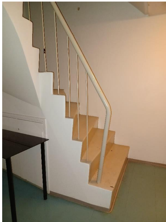
Kuva 112 Sisätilojen portaikkoja. Vasemmalla alkuperäisiä, kivisiä lattia- ja porraspintoja, ja oikealla vanhaa, todennäköisesti asbestipitoista muovilaattalattiaa. Oikeanpuoleiset portaat johtavat katolle.
