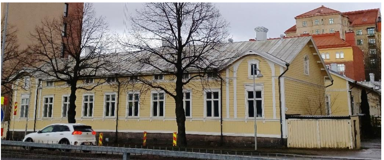
Kuva 41 Rakennus Ratapihankadun toiselta puolelta kuvattuna. Ulkoasu detaljeineen on säilynyt miltei ennallaan alkuperäiseen nähden.
