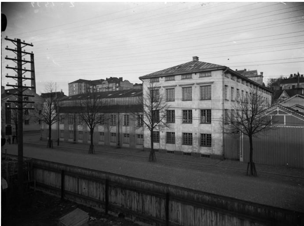
Kuva 14 Pharmakonin kiinteistöt Ratapihankadun puolelta. Vasemmassa reunassa näkyy Valion kiinteistön, Ratapihankatu 24:n, pääty alkuperäisessä asussaan. (Kuva: Turun Museokeskus / Mauno Mannelin 1930–39.)
