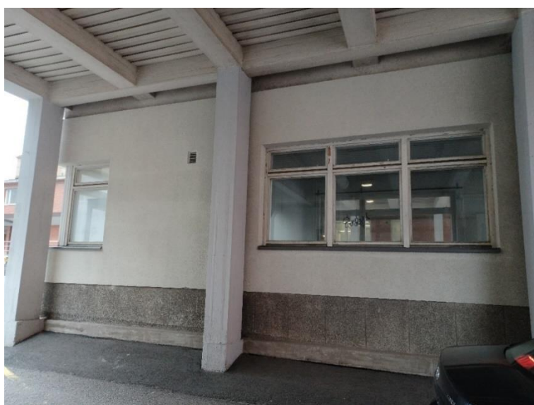
Kuva 101 Ajurinkadun puoleinen osa sisään-ajoväylän kohdalta. Tässä osassa on ilmeisesti sijainnut grillikioski.
