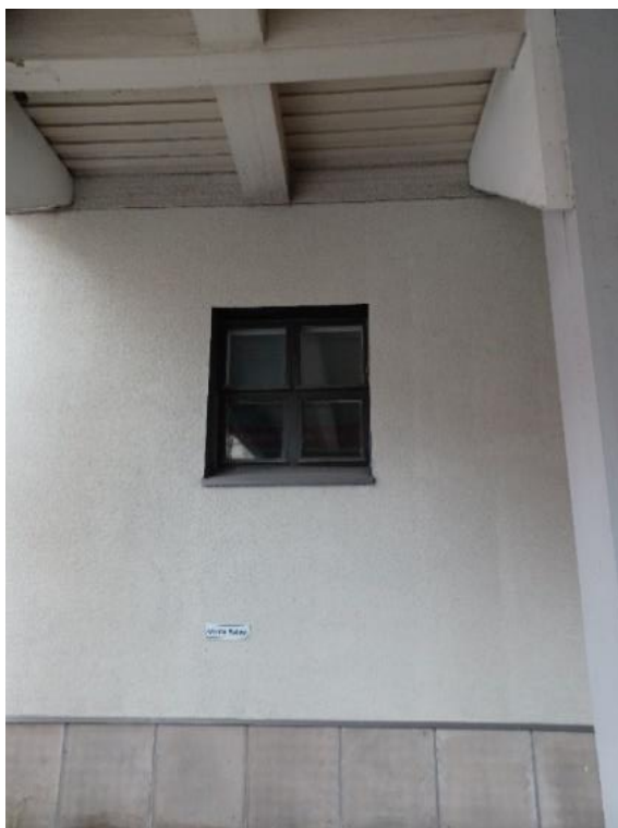
Kuva 75 Muutama alkuperäinen puupuitteinen, pieniruutuinen ikkuna on säilynyt.
