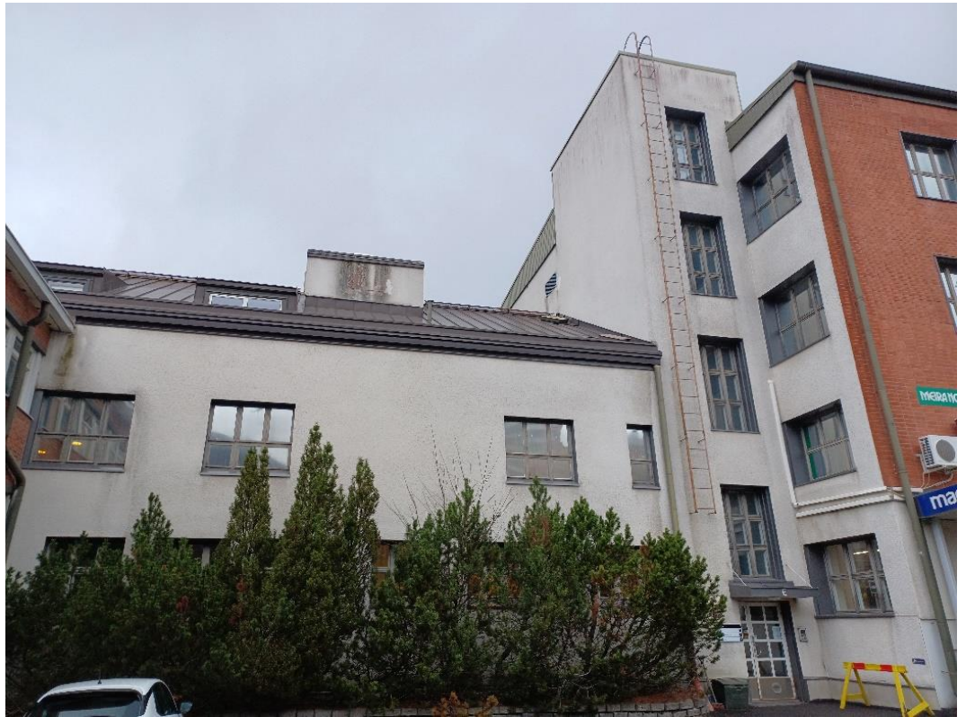
Kuva 79 (yllä) Sisäpihan puolelta rakennuksessa on vielä alkuperäisiä piirteitä, kuten vaaleaksi rapattu julkisivu. Rakennuksen pääty on jäänyt osittain uudemman ja korkeamman funkkismeijerin sisään.
