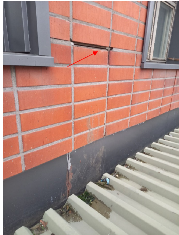
Kuva 14. Julkisivun tiililaatat ovat vääntyilleet julkisivussa on rakoja, joista sadevesi pääsee eristetilaan
