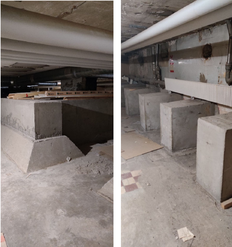
Kuva 3. Rakennuksen perustuksia on vahvistettu 1990-luvulla.
