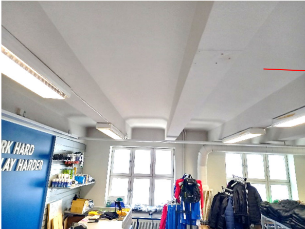
Kuva 18. Toisen ja ensimmäisen kerroksen välipohjasta alalaatta on purettu pieneltä alueelta. Muualla kerroksessa alalaattapalkisto on jäljellä.
