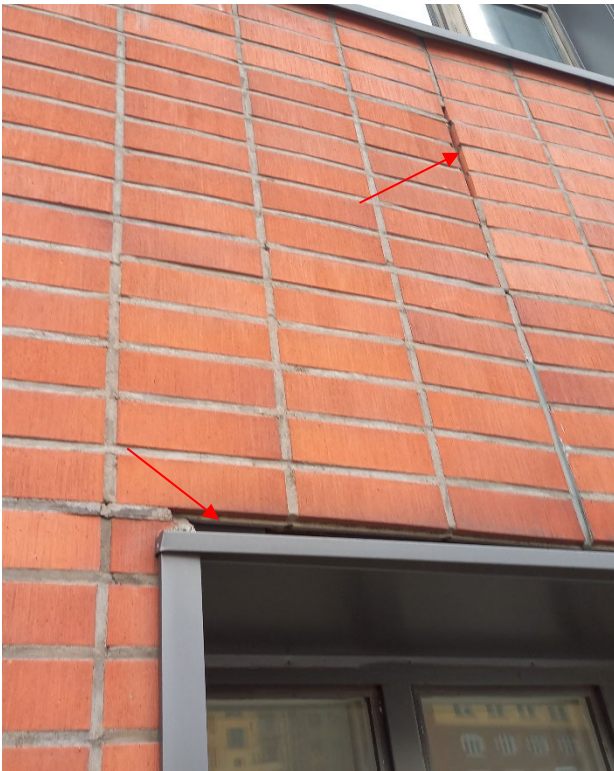
Kuva 14. Julkisivun tiililaatat ovat vääntyilleet julkisivussa on rakoja, joista sadevesi pääsee eristetilaan
