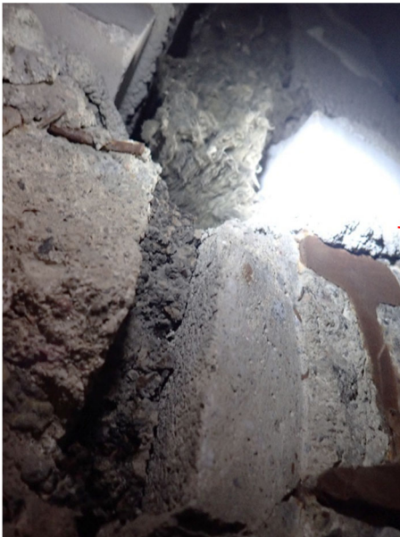
Kuva 12. IV-konehuoneen ulkoseinärakenne alkuperäisen seinän ja 1990-luvulla tehdyn korotuksen liittymästä. Vasemmalla olevan valokuvan yläosassa näkyy harkkoseinä, jossa lämmöneristeenä on mineraalivillaa. Alaosassa on vanhan ikkuna-aukon ylityspalkki ja sisäpinnan korkkieristys/betonisisäkuori.
