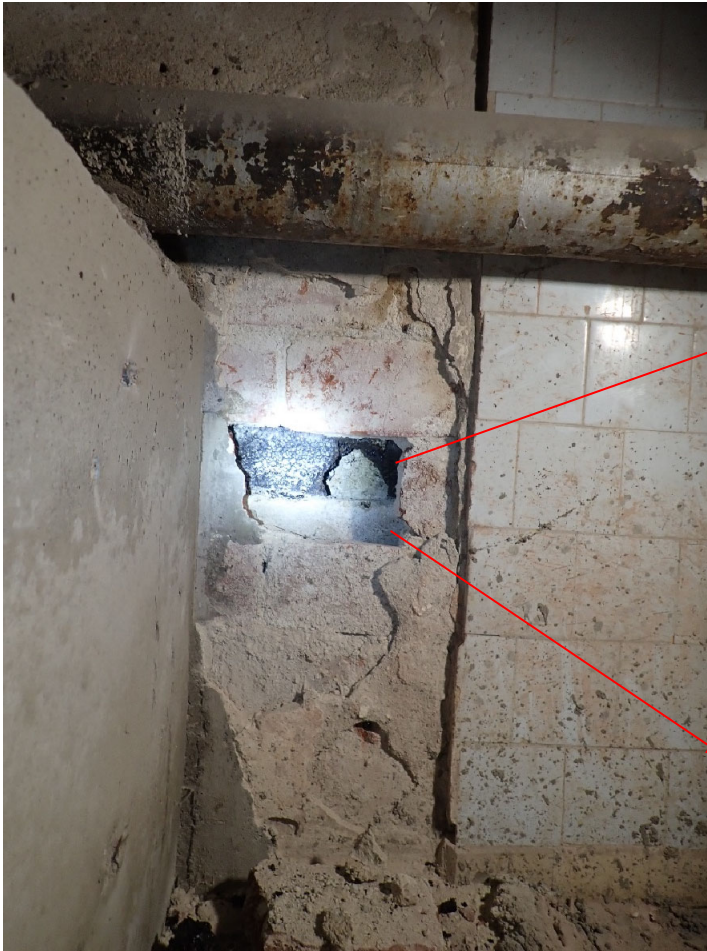
Kuva 9. Maanvastainen seinärakenne vaihtuu n. 60 cm korkeudella kellarin lattiatasosta.
