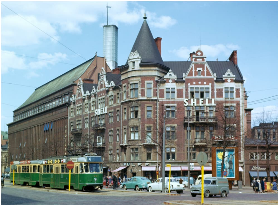
Kuva 12. Stockmannin tavaratalo 1960-luvulla, Argoksen talo, "Wulfin kulma" ennen rakennuksen rungon purkua. Kuva Helsingin kaupungin museo.
