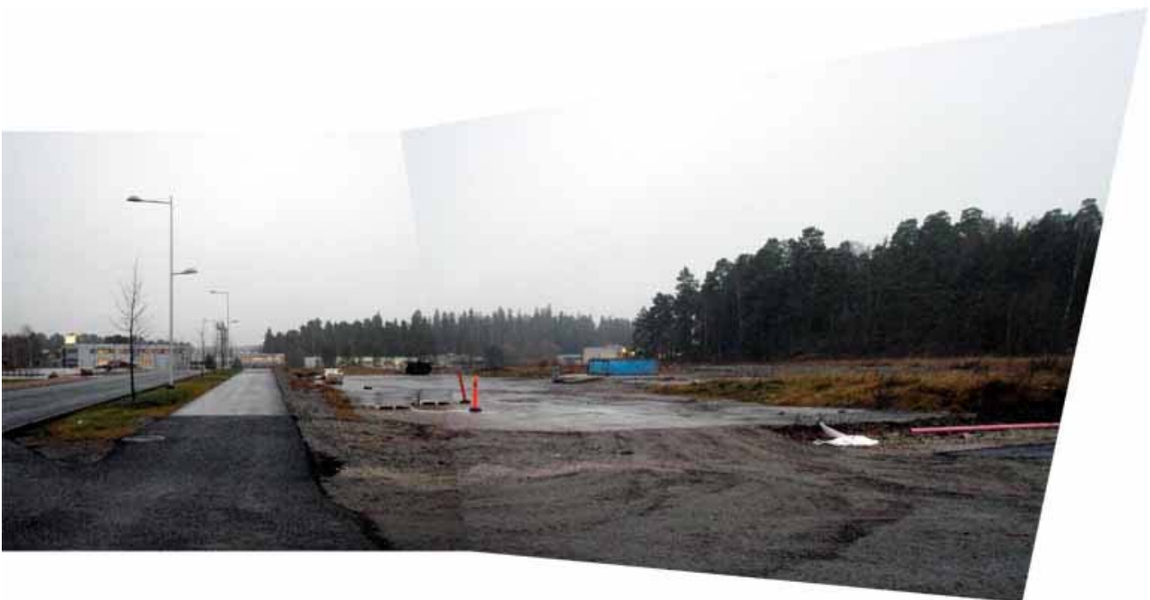
PANORAAMANÄKYMÄ SUUNNITTELUALUEELLE TYÖNJOHTAJAN- JA KYMPINKADUN RISTEYKSESTÄ
